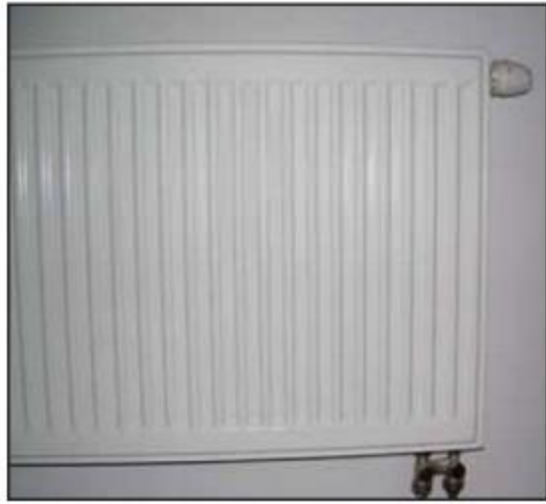
Рисунок 1.13 - Панельний радіатор з терморегулюючим вузлом нижнього підключення Герц 3000
