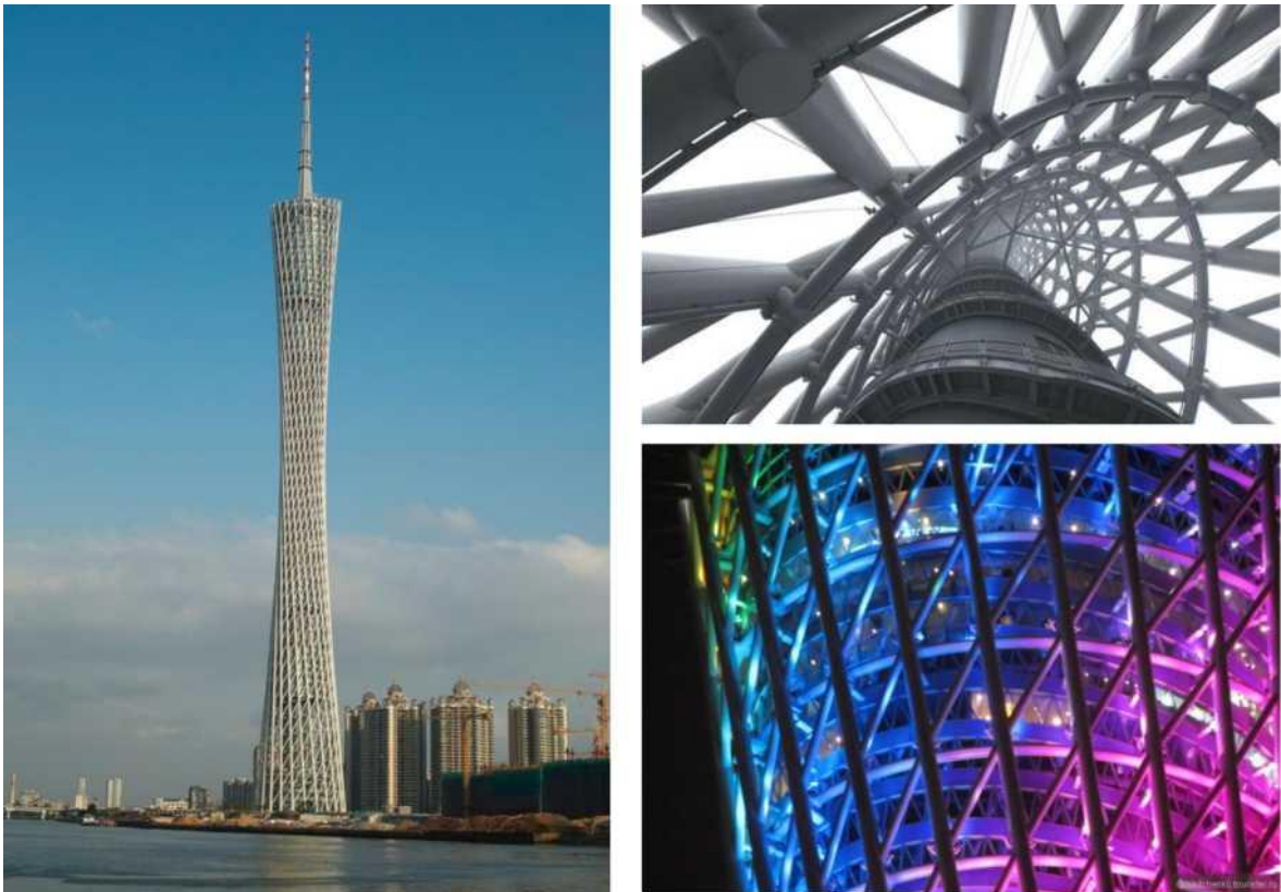
Рисунок 1.3 - Телевежа «Canton Tower» заввишки 600м (м. Гуанчжоу) а - загальний вигляд вежі; б, в - оболонка з труботонних елементів
