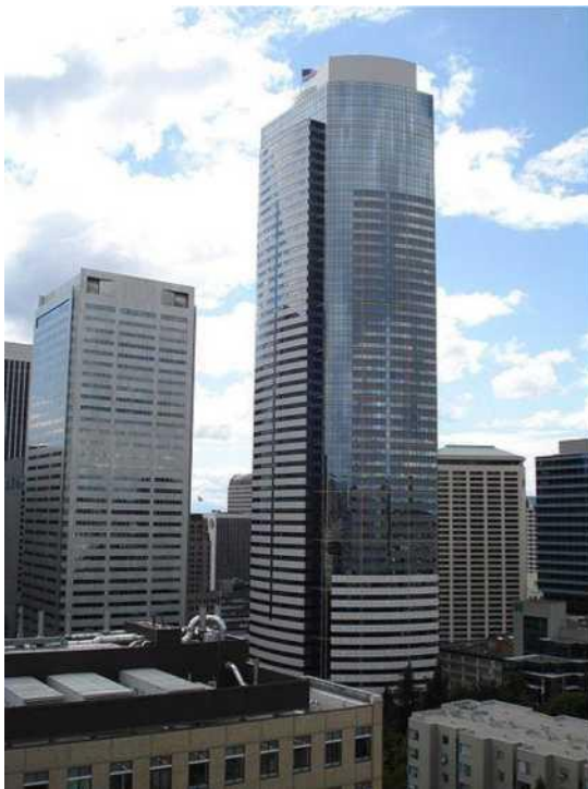
Рисунок 1.4 - 58-поверхова висотна будівля «Two Union Square» побудоване за системою «SWMB» (м Сієтл) а - загальний вигляд будівлі; б - план типового поверху
