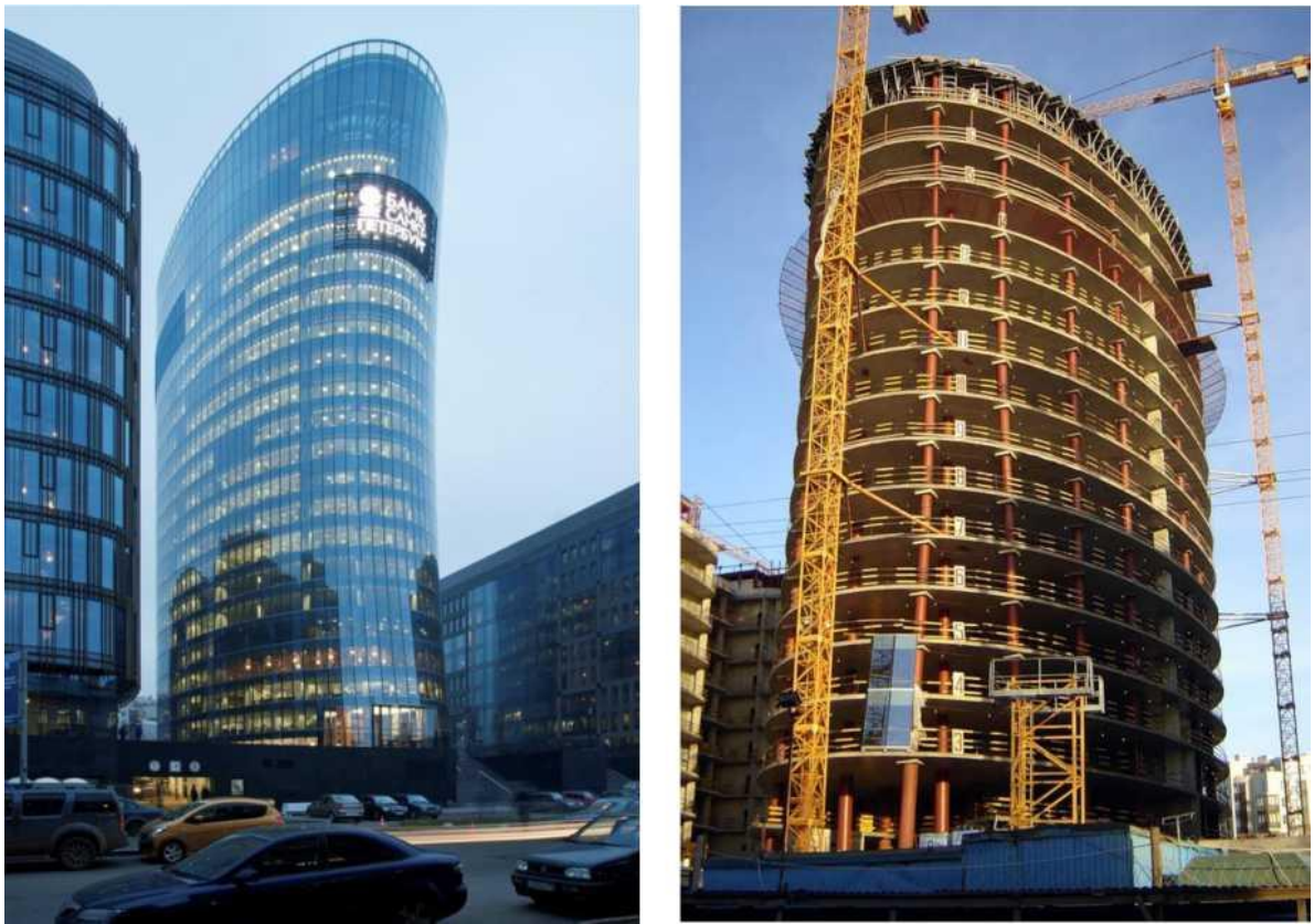
Рисунок 1.1 - Загальний вигляд будівлі ВАТ «Банк Санкт-Петербург»
