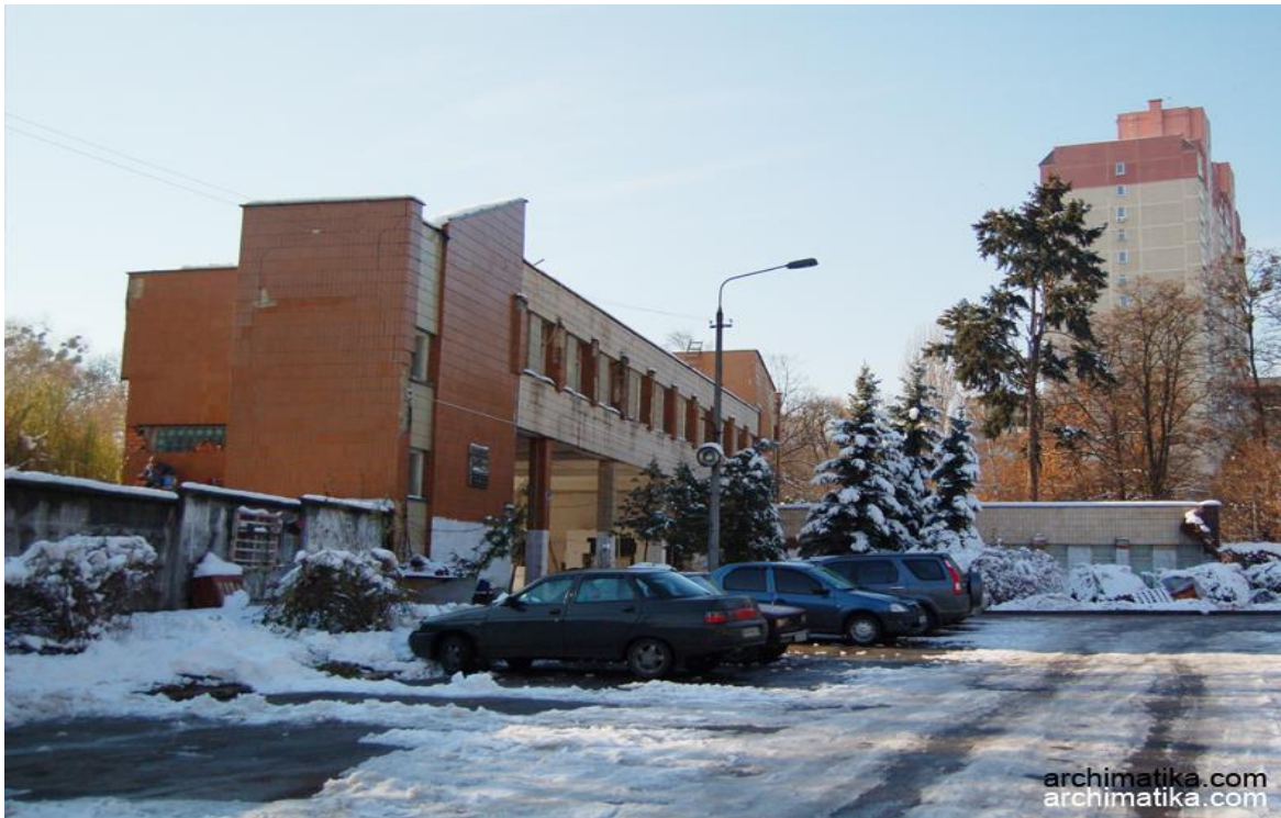
Рисунок 2.20 - Вид будівлі до реконструкції
