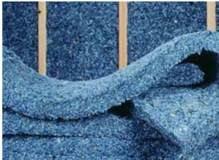
Рисунок 1.7 – Теплоізоляційний матеріал з бавовняної вати
