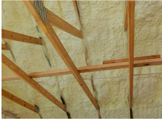
Рисунок 1.14 – Теплоізоляційний матеріал з пінокарбамидно-формальдегідного пінопласту
