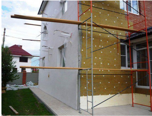
Рисунок 2.1 - Технологія монтажу мокрого фасаду
