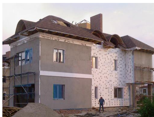
Рисунок 2.11 – Система скріпленої теплоізоляції
