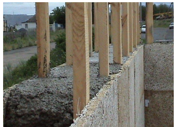
Рисунок 2.6 - Незнімна опалубка з ДСП
