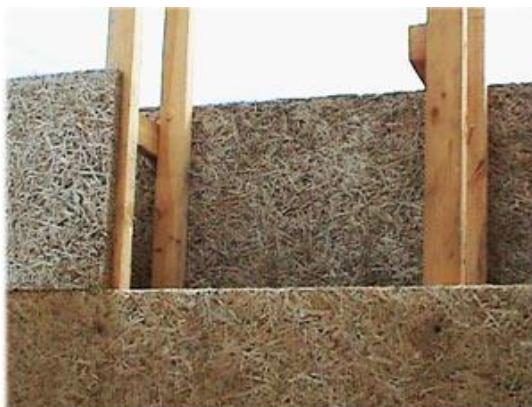
Рисунок 2.6 - Незнімна опалубка з ДСП
