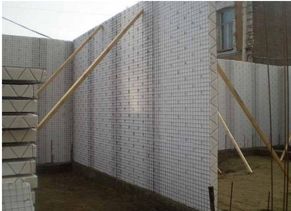
Рисунок 2.8 - Будівельна конструкція МДМ - панель
