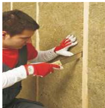
Рисунок 2.10 - Легка штукатурна фасадна система PAROC
