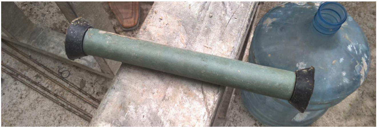
Рисунок 2.13 – Конструкція ПВХ втулок для утримання анкерних стяжок
