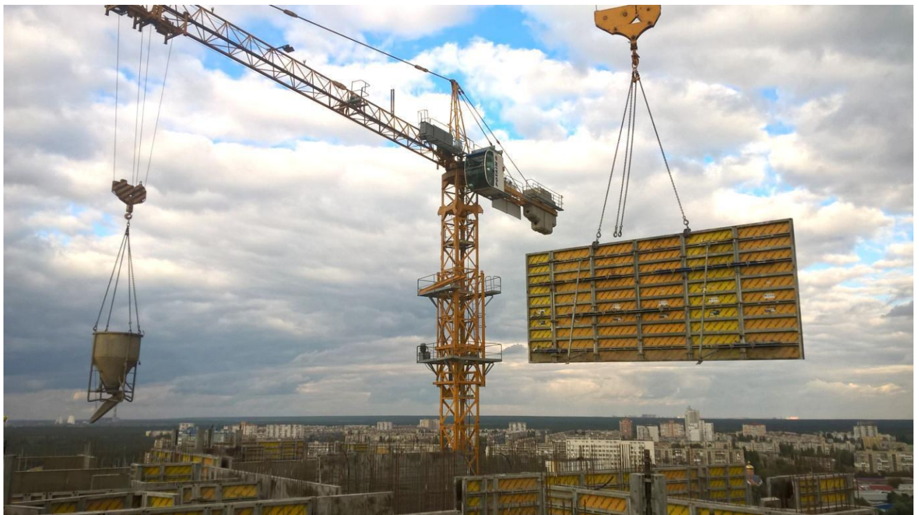
Рисунок 2.12 – Подача щитів опалубки на монтажний горизонт будівлі
