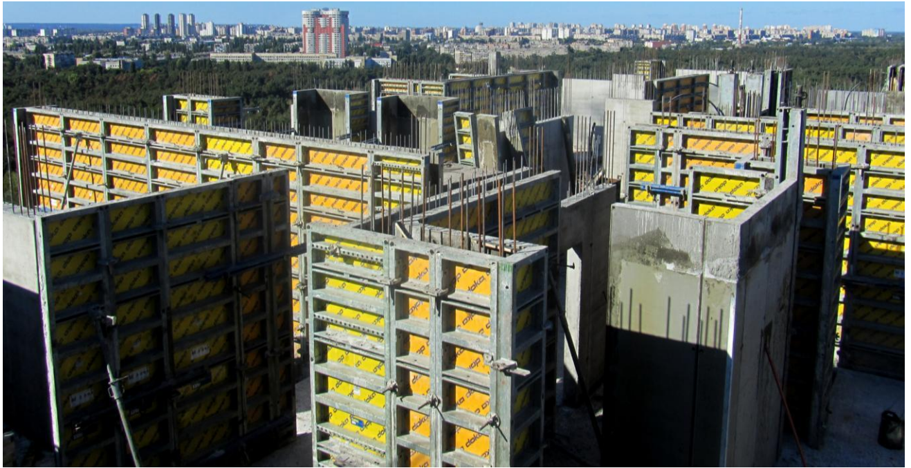
Рисунок 2.17 – Зведення каркасу будівлі з використанням комбінованої щитової опалубки “Doka”
