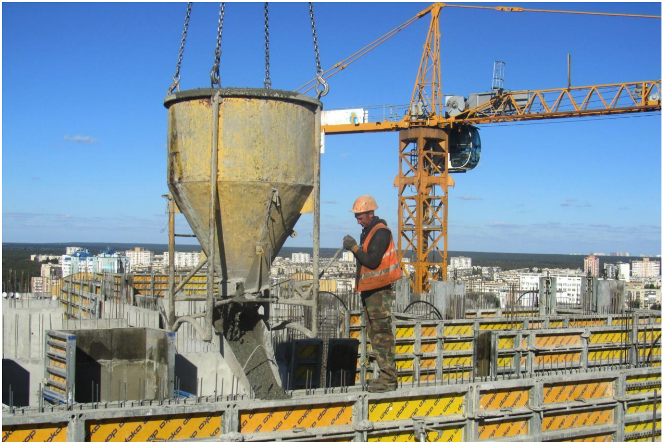
Рисунок 2.8 – Бетонування вертикальних конструктивних елементів
