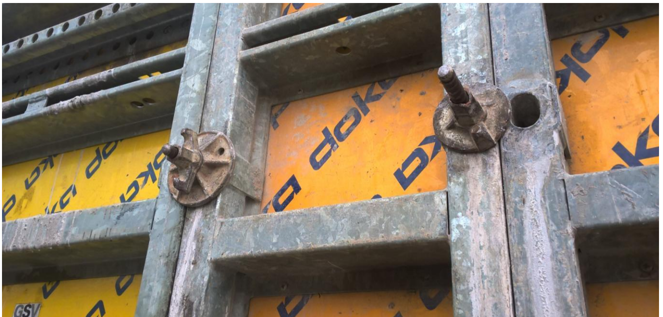
Рисунок 2.14 – Влаштування анкерних стяжок в щитах опалубки
