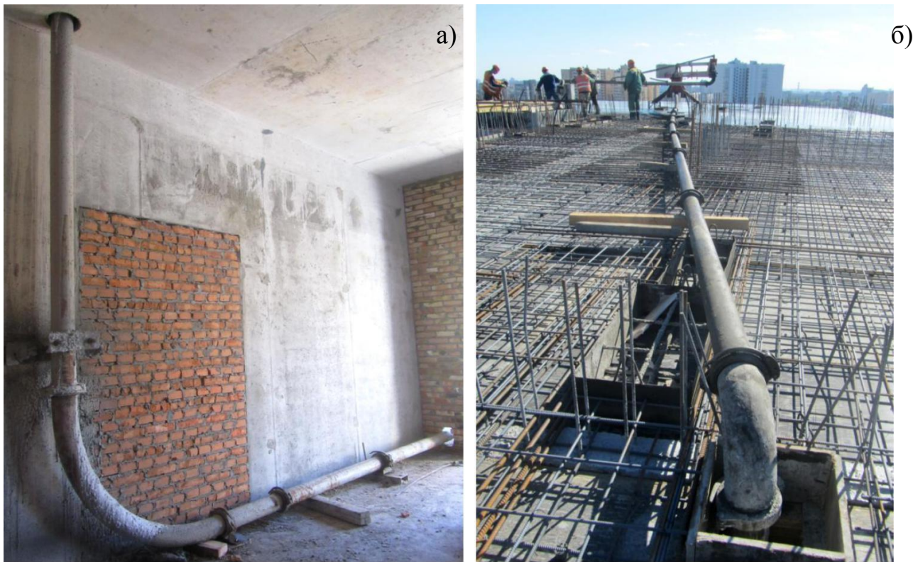
а – всередині будівлі; б – на технологічній захватці монтажного горизонту
