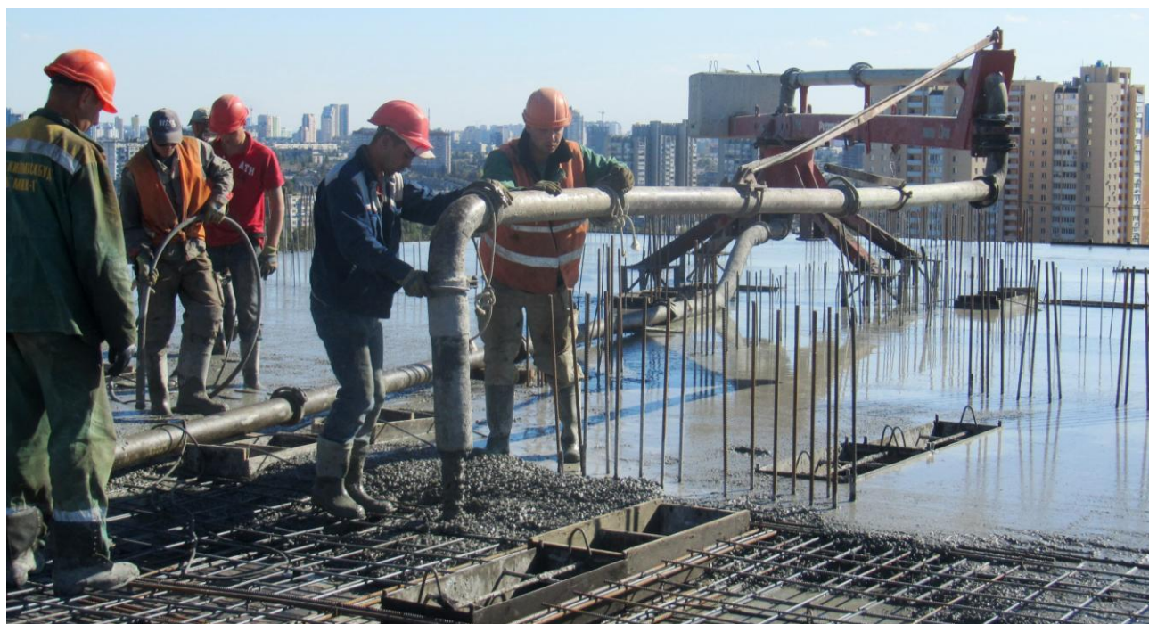
Рисунок 2.7 – Бетонування плити перекриття за допомогою механічної розподільної стріли “Putzmeister”
