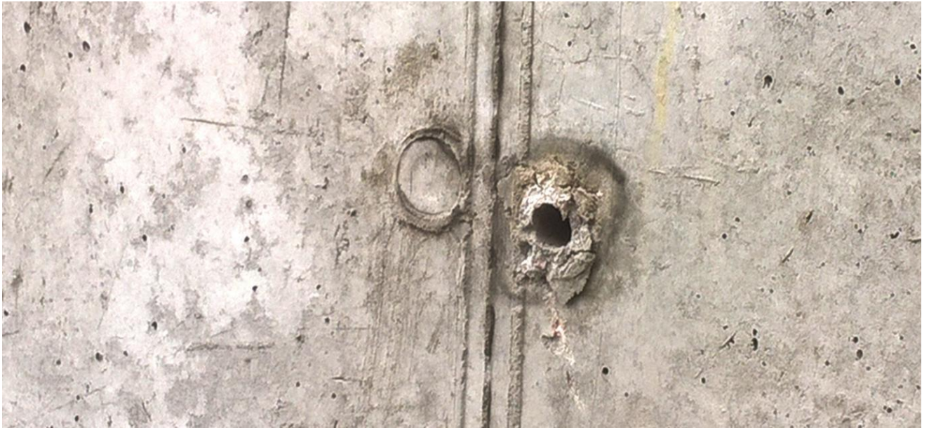
Рисунок 2.15 – Отвори для втулок, утворені в тілі бетонної конструкції
