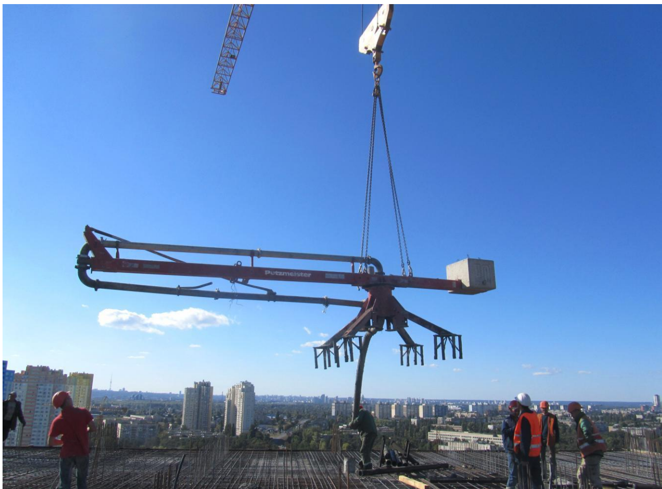
Рисунок 2.6 – Монтаж механічної розподільної стріли “Putzmeister” на технологічній захватці монтажного горизонту
