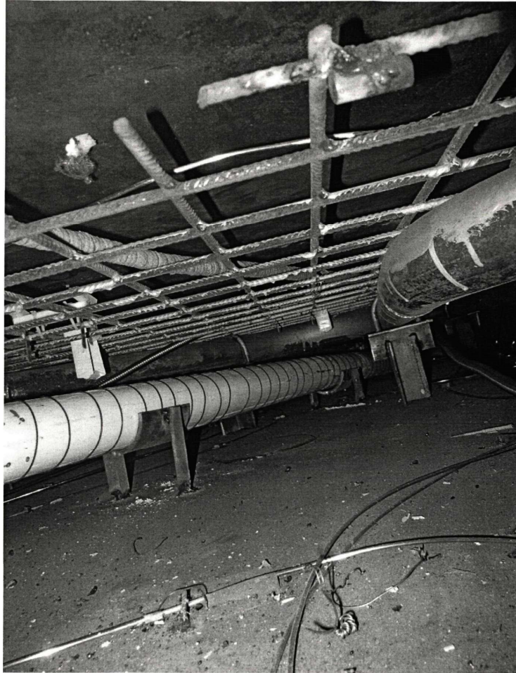
Рисунок 3.4 - Вид порожнини з торця до бетонування, насичення порожнини, бетоновод
