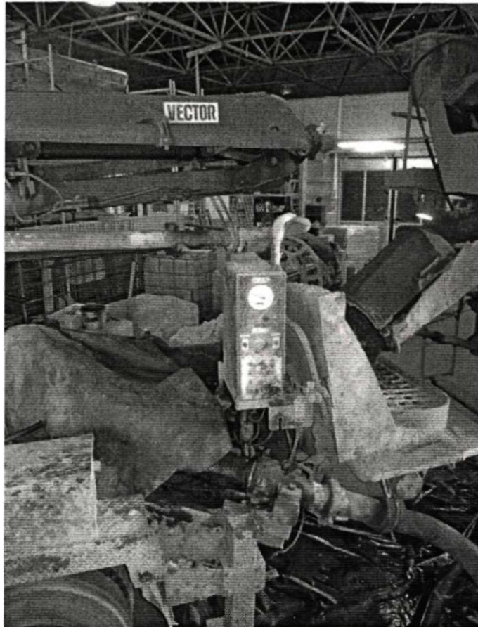
Рисунок 3.8 - Подача бетонної суміші в приймальний бункер бетононасоса
