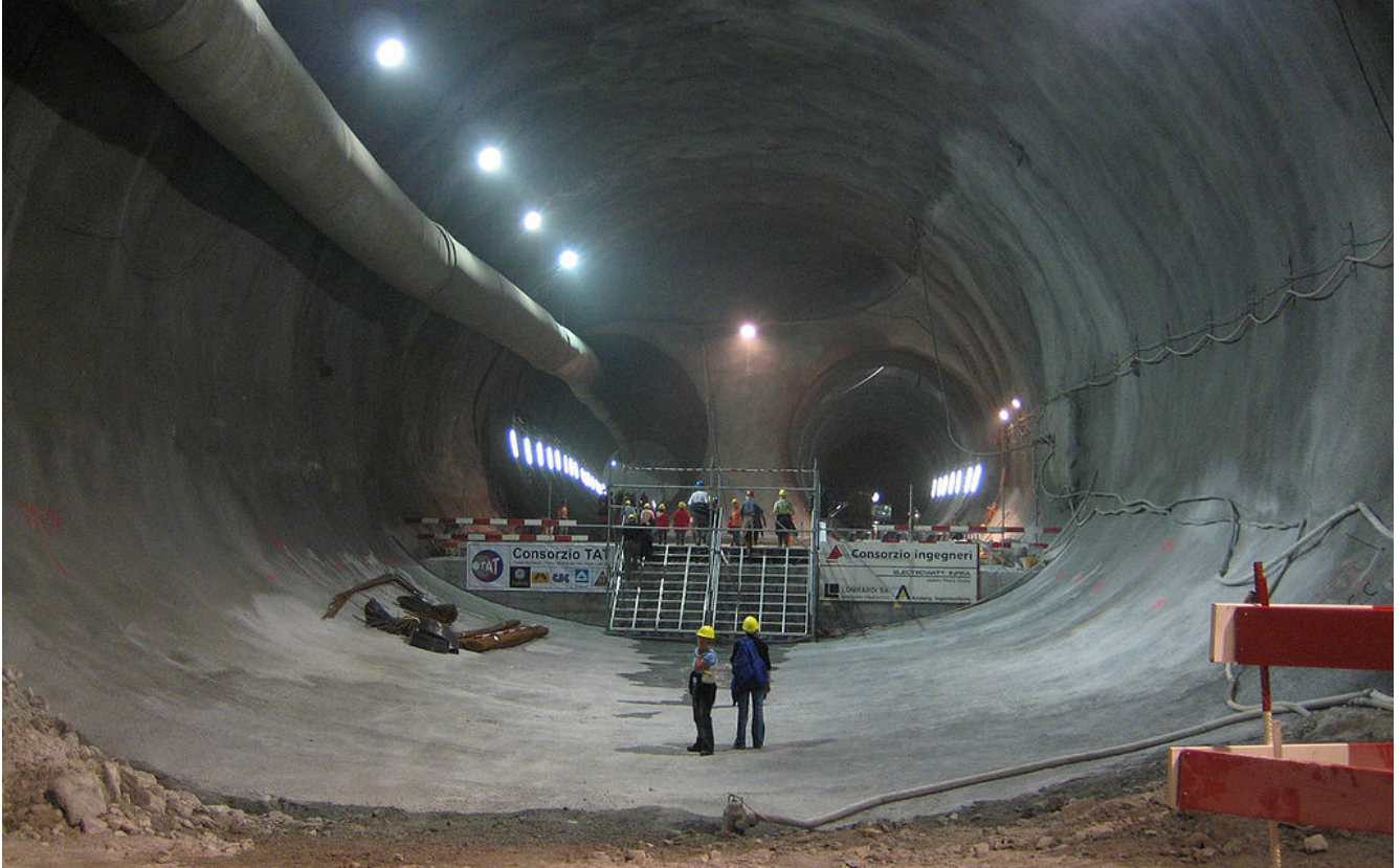
Рисунок 1.6 – Будівництво Готардського базового тунелю (багатофункціональна станція Фейдо).
