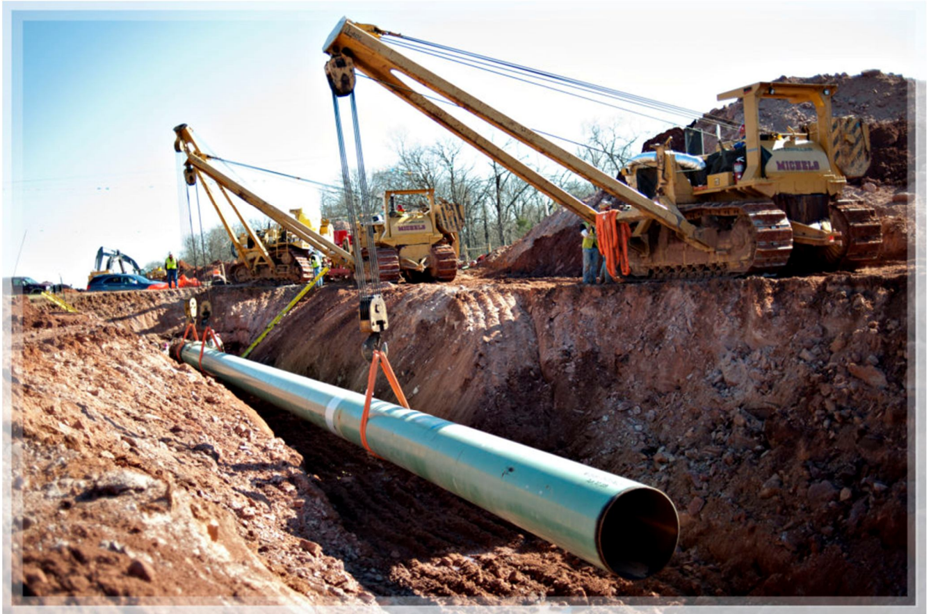
Рисунок 1.7 – Виконання організаційно-будівельного процесу зовнішніх інженерних мереж
