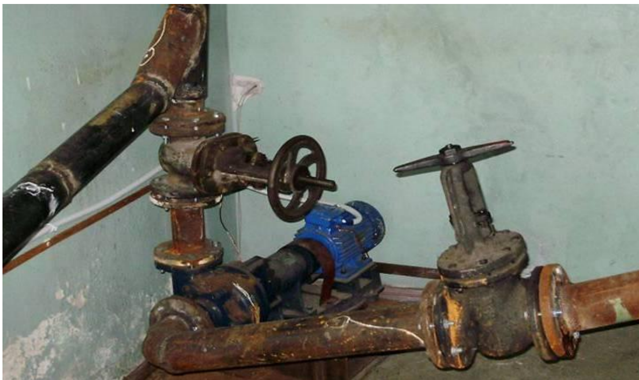
Рисунок 4.3, – Встановлення у циркуляційну систему додаткового насоса
