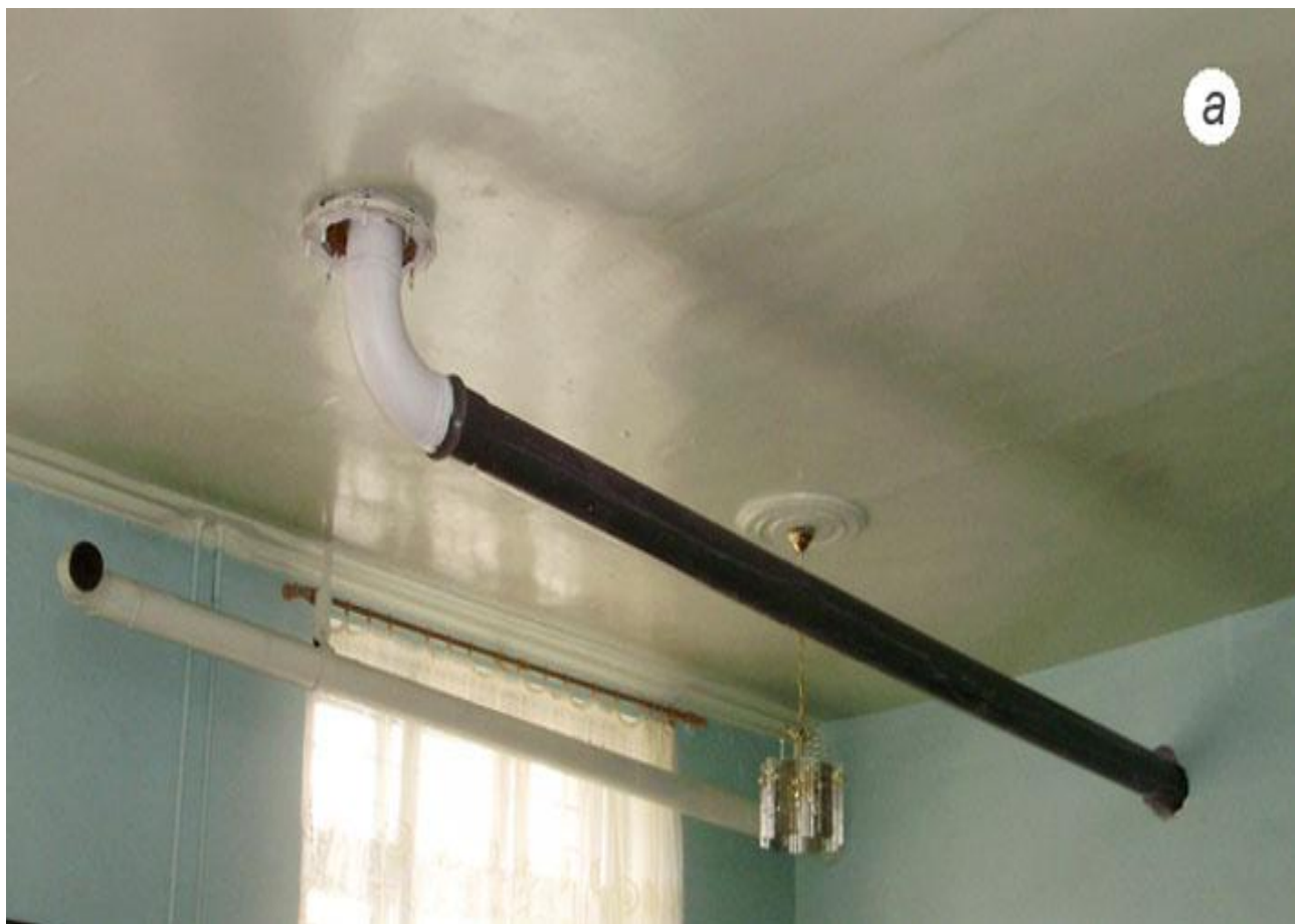
Рисунок 4.11 (а), – Вивід зливної труби крізь перекриття
