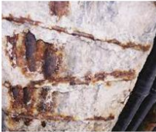
Рисунок 2.8 – Корозійні пошкодження бетону
