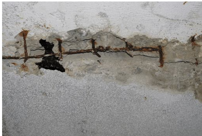
Рисунок 3.8 –Діаграма тріщин в бетоні
