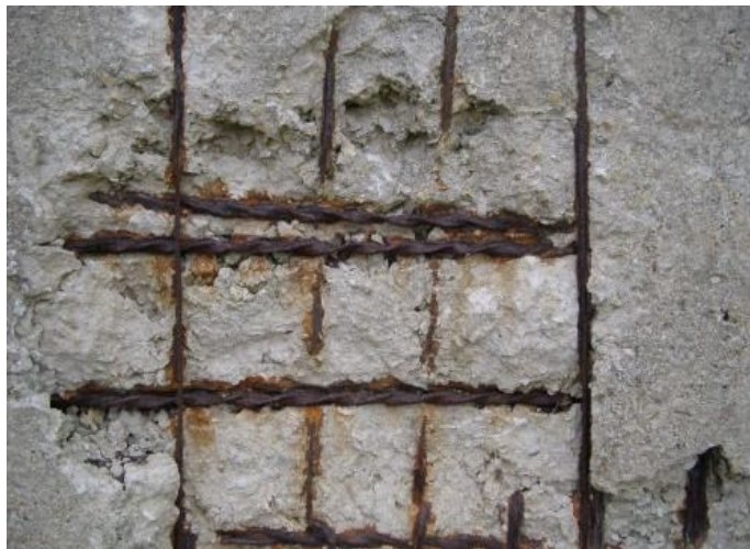
Рисунок 2.14 – Карбонізація бетону
