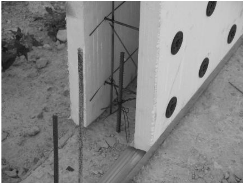
Рисунок 3.14 – Конструктивні елементи системи PLASTBAU:
