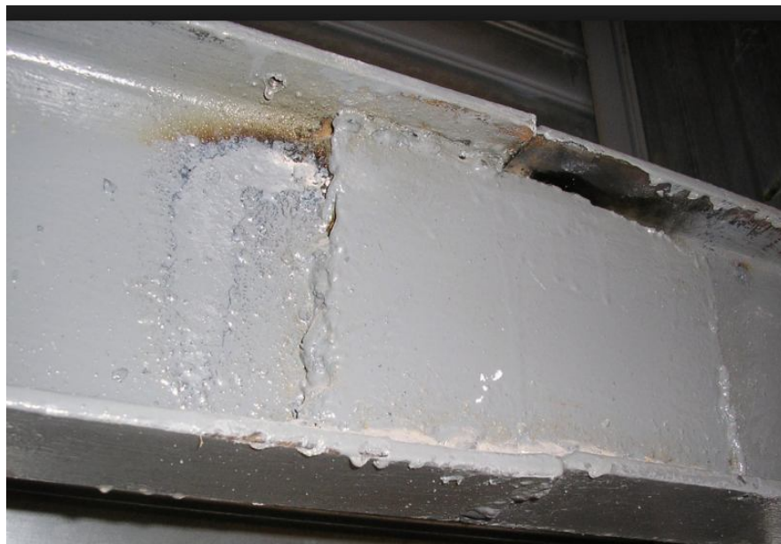
Рисунок 2.23 – Відбір зразків у металевих конструкціях
