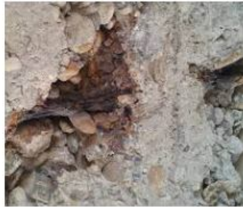
Рисунок 2.8 – Корозійні пошкодження бетону
