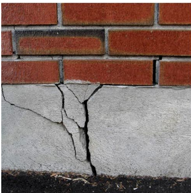
Рисунок 2.10 – Тріщини в огорожувальних конструкціях від нерівномірностей осідання фундаментів
