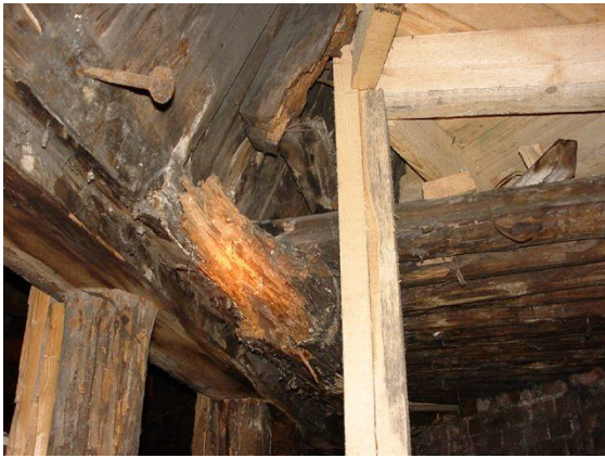
Рисунок 1.3 - Руйнівна діяльність грибків дерев'яних та кам'яних конструкцій
