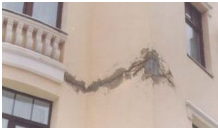
Рисунок 2.8 – Корозійні пошкодження бетону
