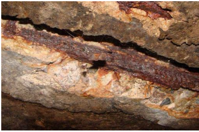
Рисунок 2.7 – Корозійні пошкодження бетонних і залізобетонних конструкцій
