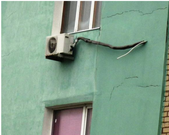
Рисунок 2.10 – Тріщини в огорожувальних конструкціях від нерівномірностей осідання фундаментів
