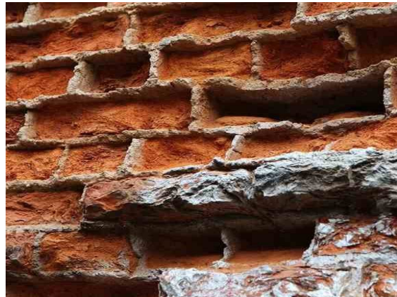
Рисунок 1.3 - Руйнівна діяльність грибків дерев'яних та кам'яних конструкцій
