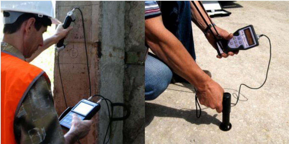
Рисунок 2.17 – Ультразвукове обстеження фундаменту
