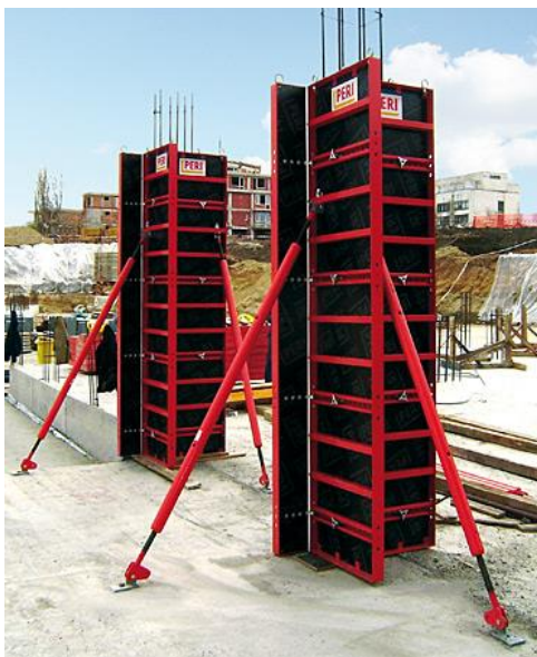
Рисунок 2.7 - Опалубка РАХ - колони : а - PERI; б - RINGER
