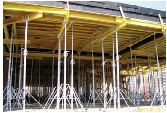
Рисунок 2.9 - Опалубка перекриттів на телескопічних стійках
