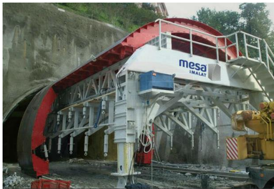
Рисунок 2.4 - Тунельна опалубка: а - MESA IMALAT; б – OUTINOOR
