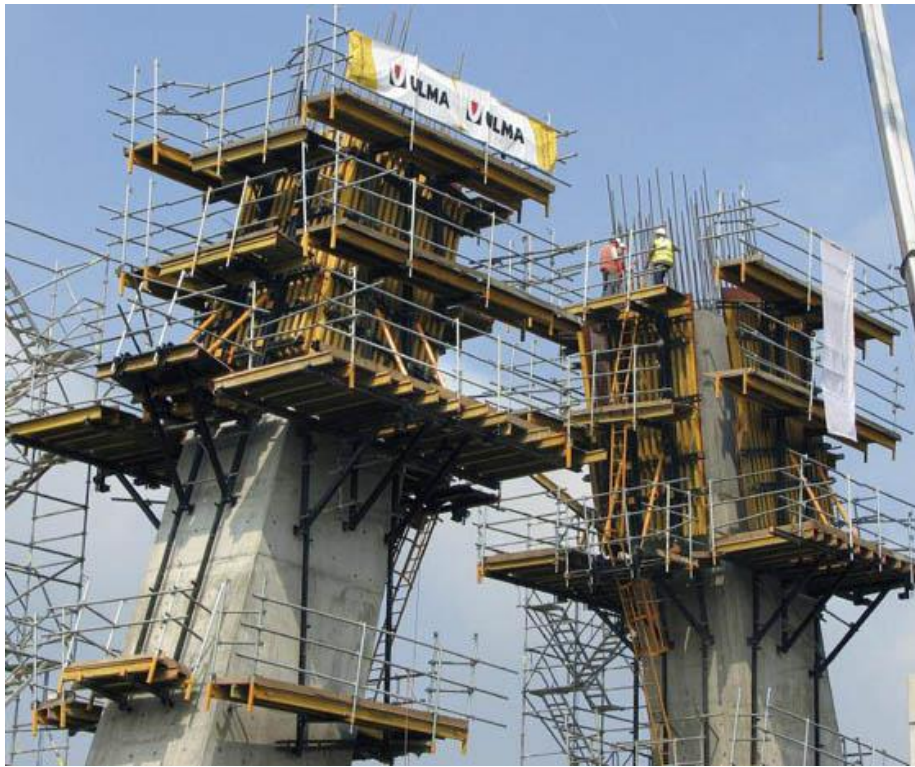
Рисунок 2.5 - Спеціальна опалубна система ENKOFORM VMK
