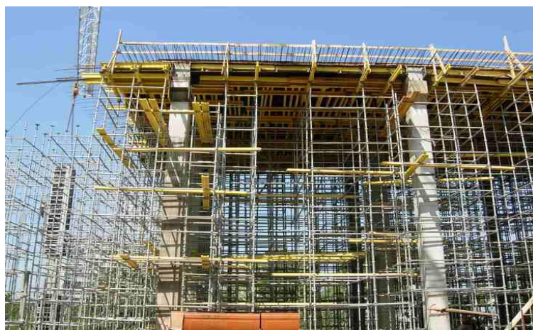
Рисунок 2.12 - Опалубка перекриттів на рамах
