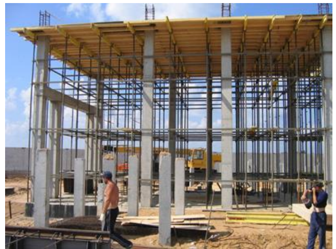
Рисунок 2.10 - Опалубки перекриттів на об'ємних стійках
