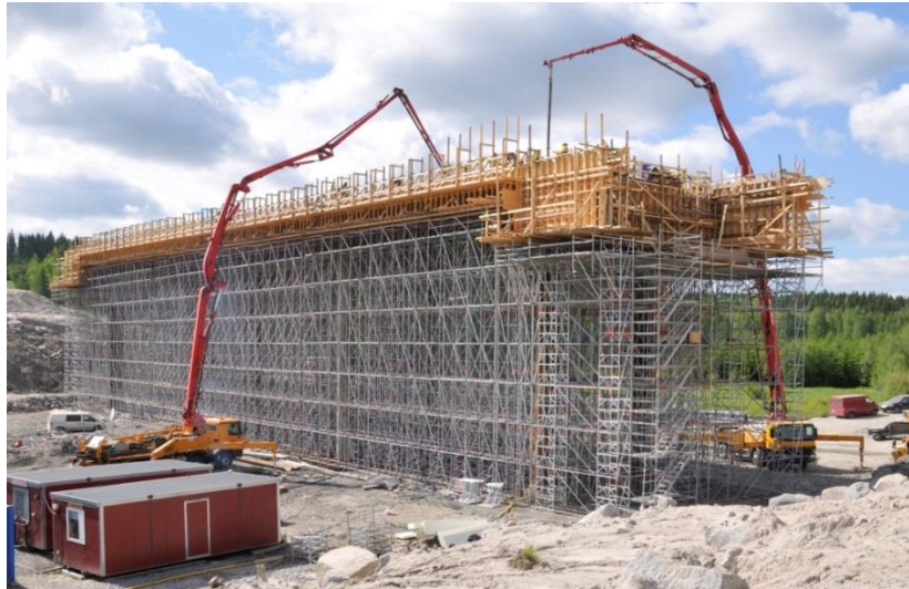
Рисунок 2.11 - Опалубка перекриттів на опорних лісах
