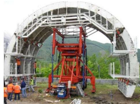
Рисунок 2.4 - Тунельна опалубка: а - MESA IMALAT; б – OUTINOOR
