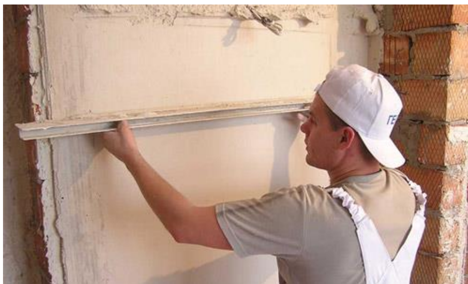
Рисунок 3.8 - Шпаклівка стін по маяках.
