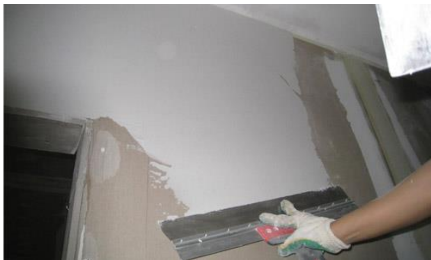
Рисунок 3.7 – Нанесення стартової шпаклівки.
