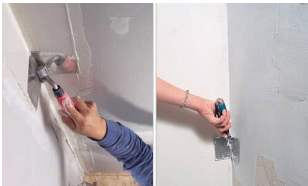
Рисунок 3.9 - Шпаклювання кутів
