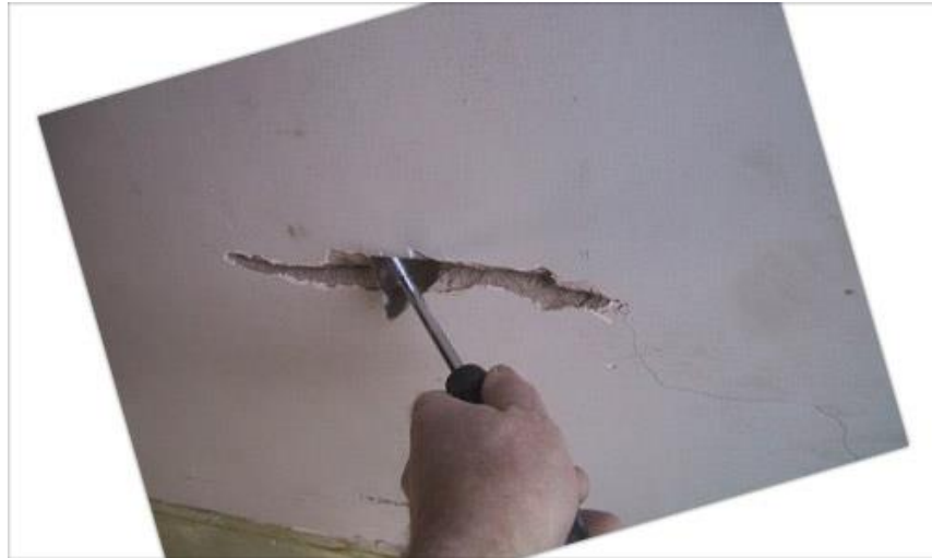
Рисунок 3.6 - Розширення тріщин для шпаклівки.
