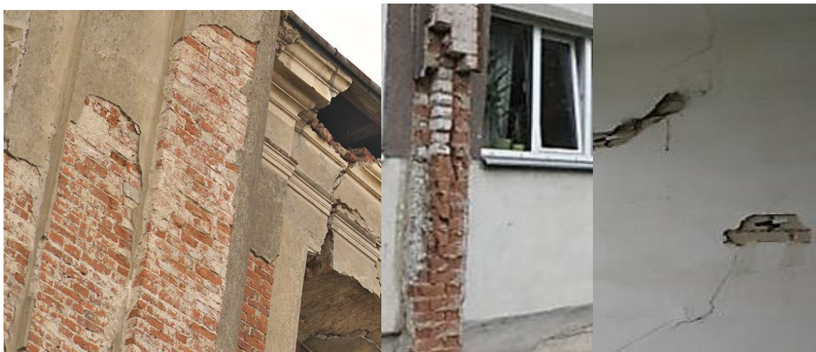
Рисунок 1.32 – Пошкодження стін
