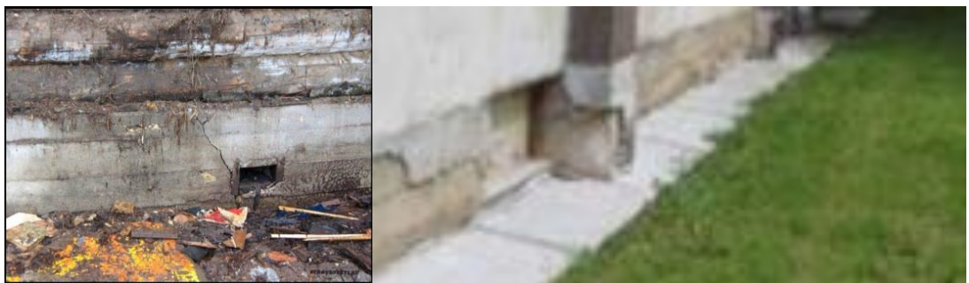
Рисунок 1.31 – Пошкодження фундаментів
