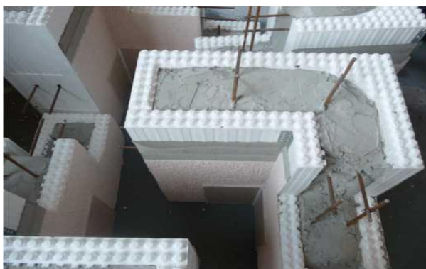
Рисунок 3.22 - Приклад бетонування в незнімній опалубці
