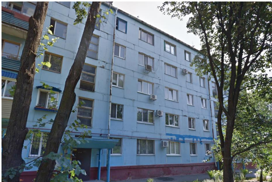
Рисунок 1.1 – Типовий будинок по вул. Рельєфній
