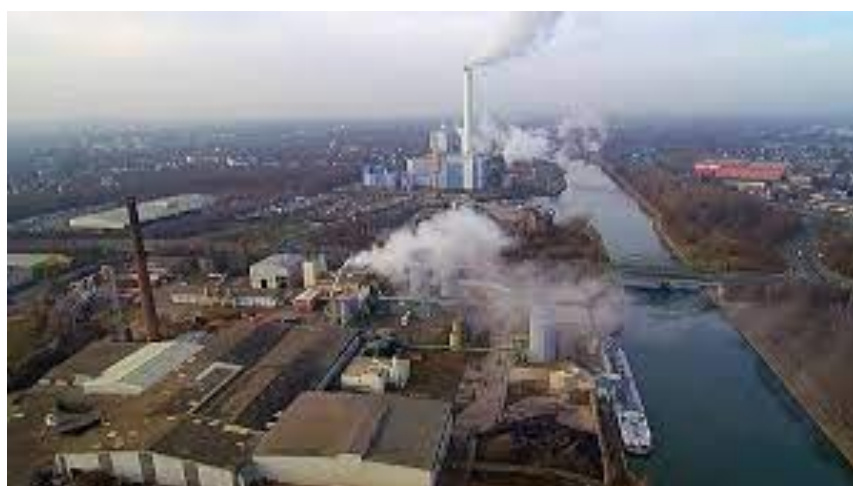
Рисунок 2.1 – Аварія на заводі із витоком сірчаної кислоти
