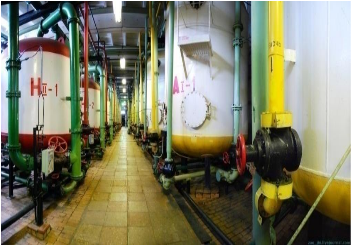
Рисунок 4.1 – Приміщення іонообмінних фільтрів ХВ цеху підготування води
