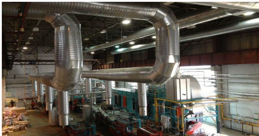
Рисунок 3.5– Приклад витяжної вентиляції в промисловому приміщенні (місцева)
