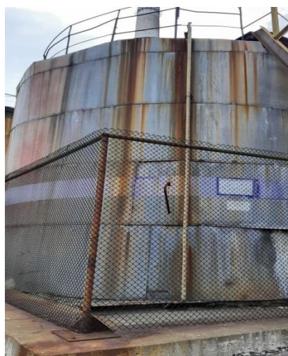
Рисунок 2.4 – Площадка для зберігання сірчаної кислоти
