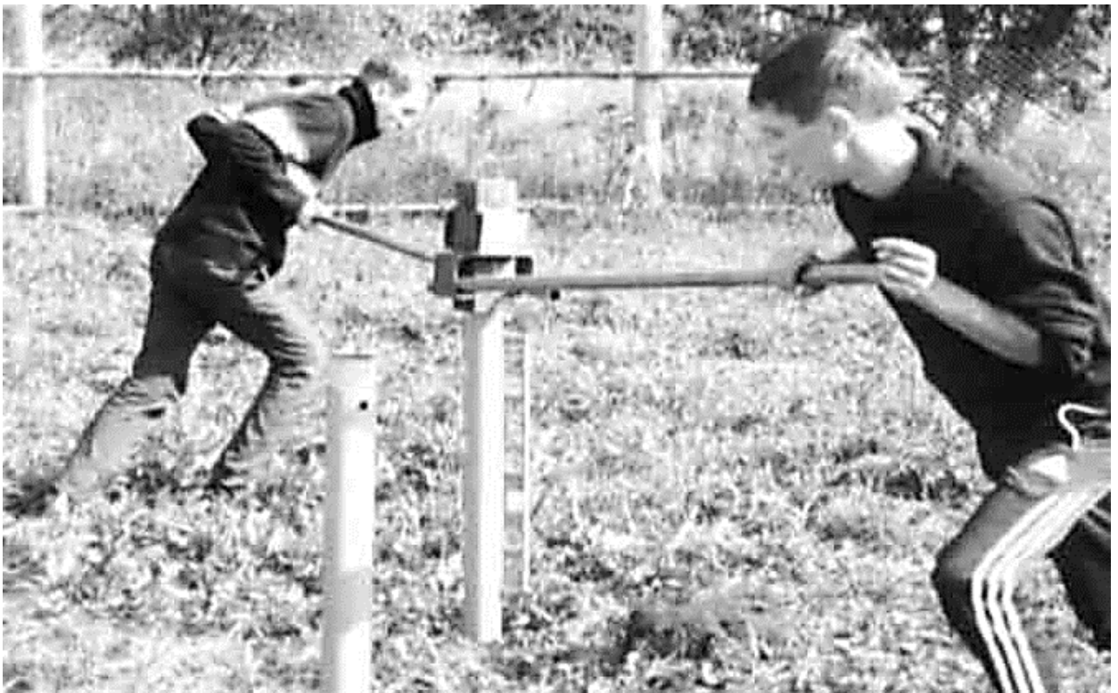
Рисунок 3.2 – Влаштування гвинтових паль
