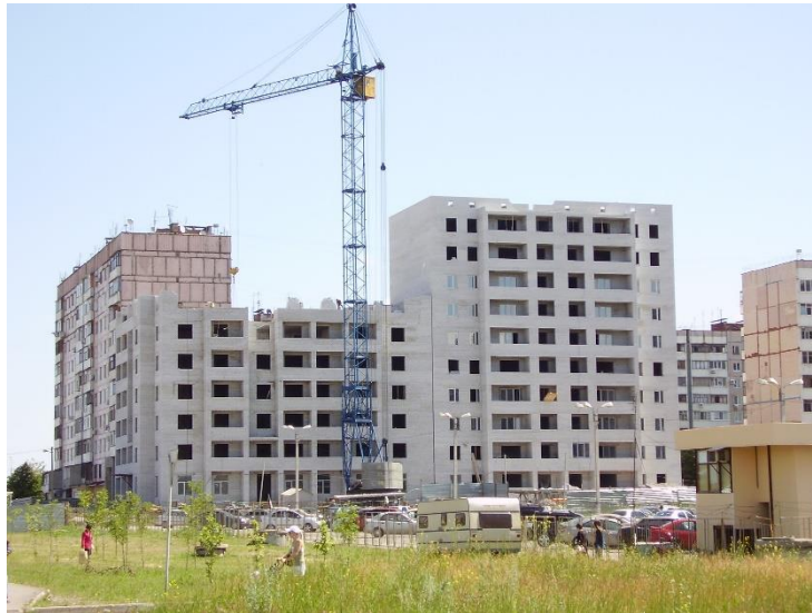
Рисунок 3.4 - Будівництво цегляних будинків у м.Запоріжжя
