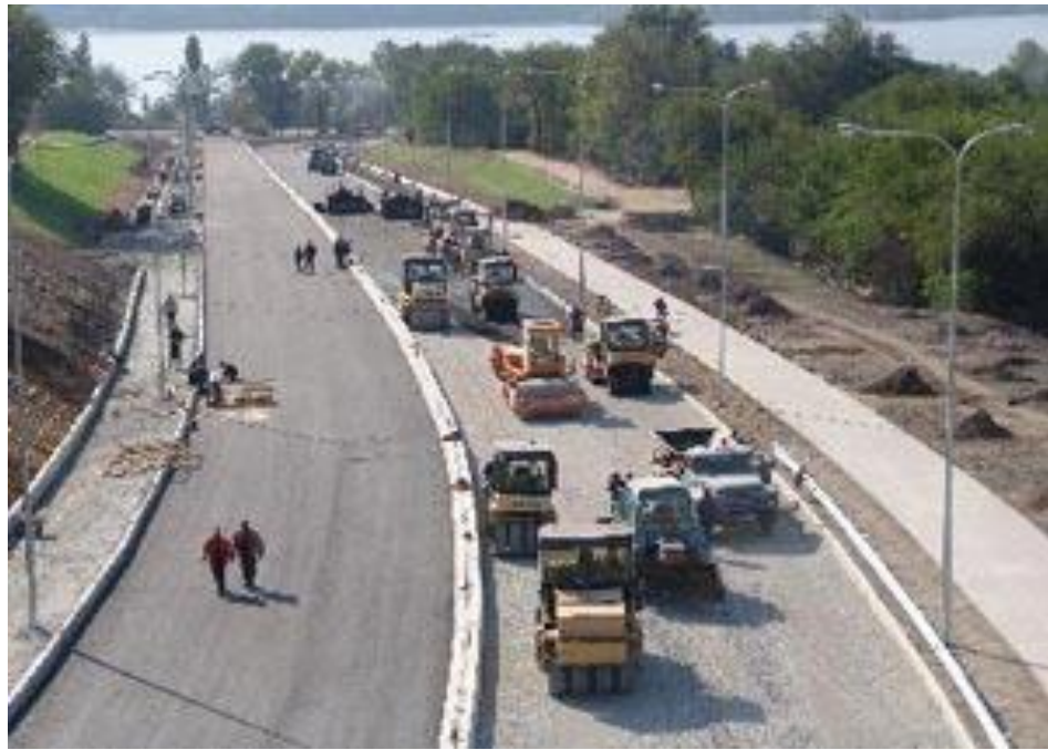
Рисунок 2.1- Будівництво автодороги вул. Перемоги до Набережної магістралі.
