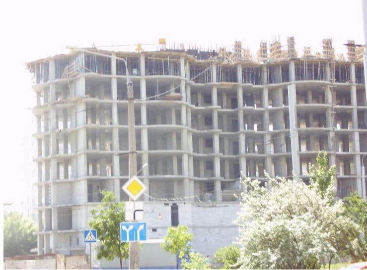
Рисунок 3.6 - Будівництво монолітних будинків у м. Запоріжжі
