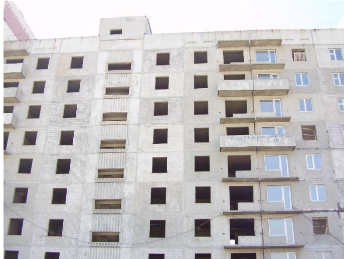
Рисунок 3.5 - Будівництво панельних будинків у м. Запоріжжя.
