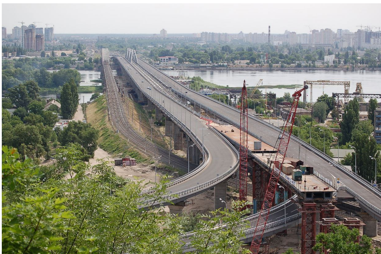
Рисунок 3.17 – Залізнично-автомобільний мостовий перехід через Дніпро в Києві Дарницький (ліворуч) і залізнично-автомобільний (праворуч) мости
