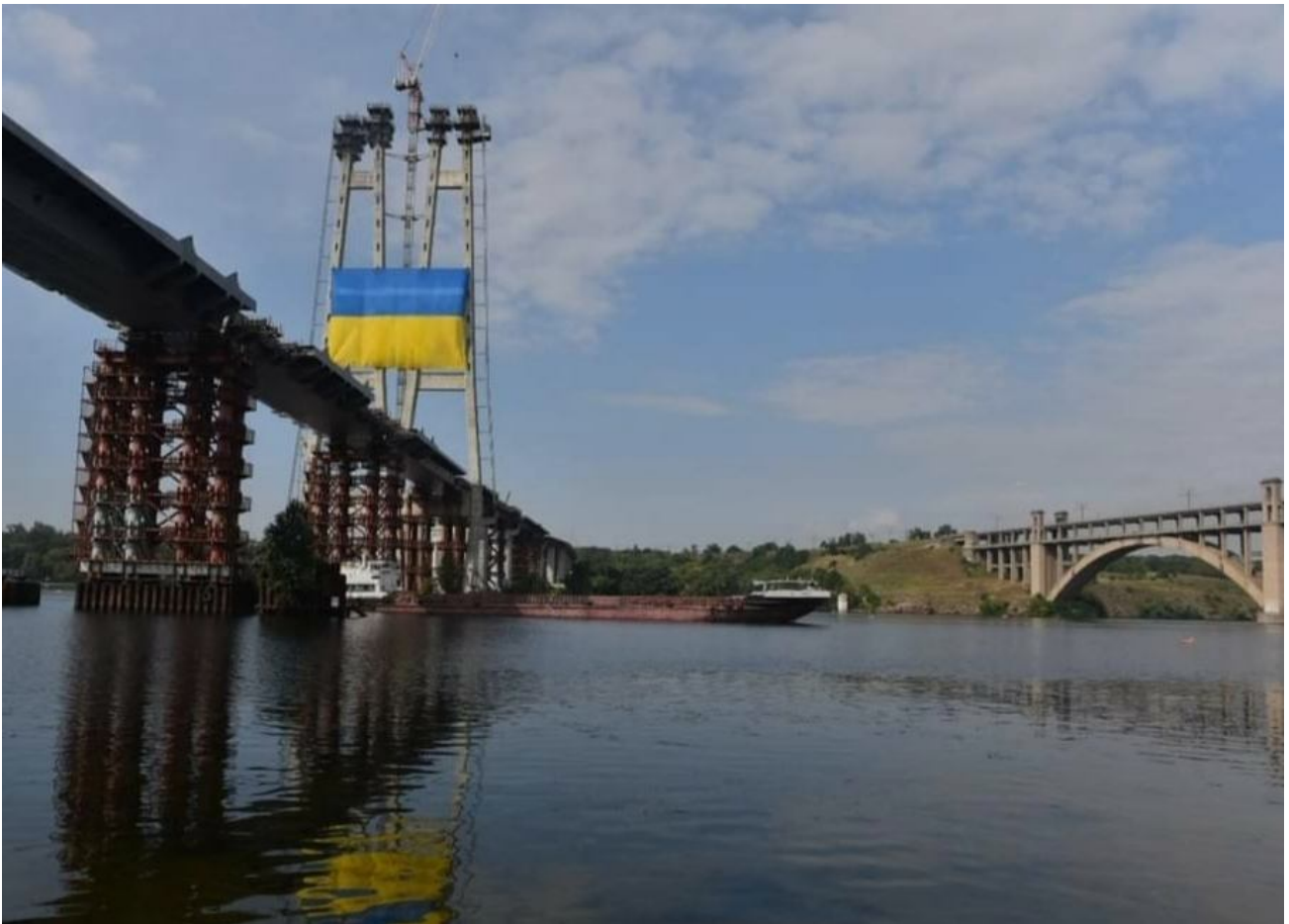
Рисунок 3.20 – Незавершене будівництво мостового переходу – під'їзд до о.Хортиця – автотранспортна магістраль через р. Дніпро у м.Запоріжжі
