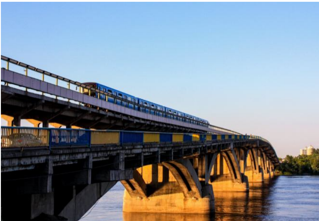
Рисунок 3.5 – Панорама мосту з набережної
