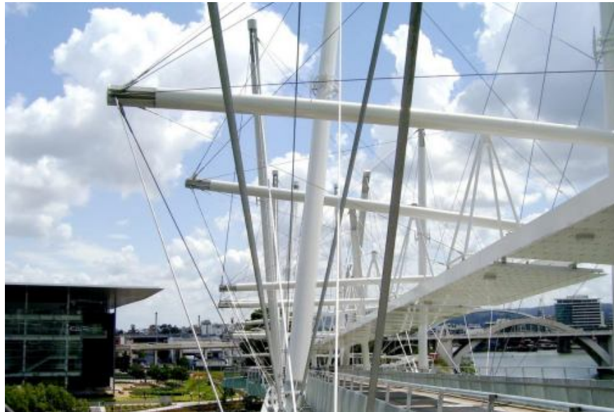
Рисунок 2.14 – Елементи системи «тенсегріті» конструкції мосту Курилпа Брідж
