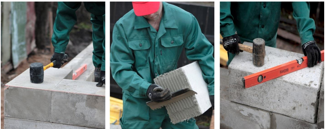
Рисунок 2.8 – Перевірка правильності ведення кладки
