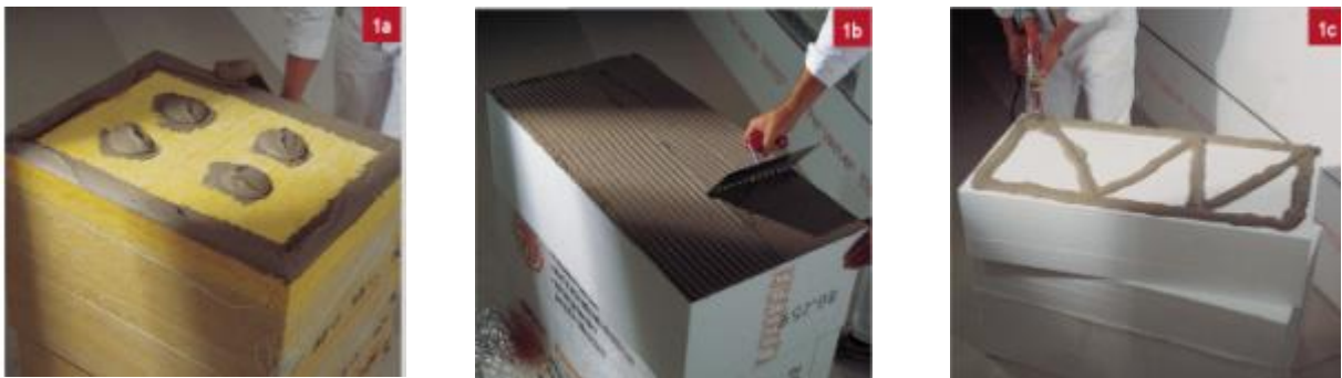
Рисунок 2.12 - Підготовка поверхні основи для наклеювання теплоізоляційних плит
