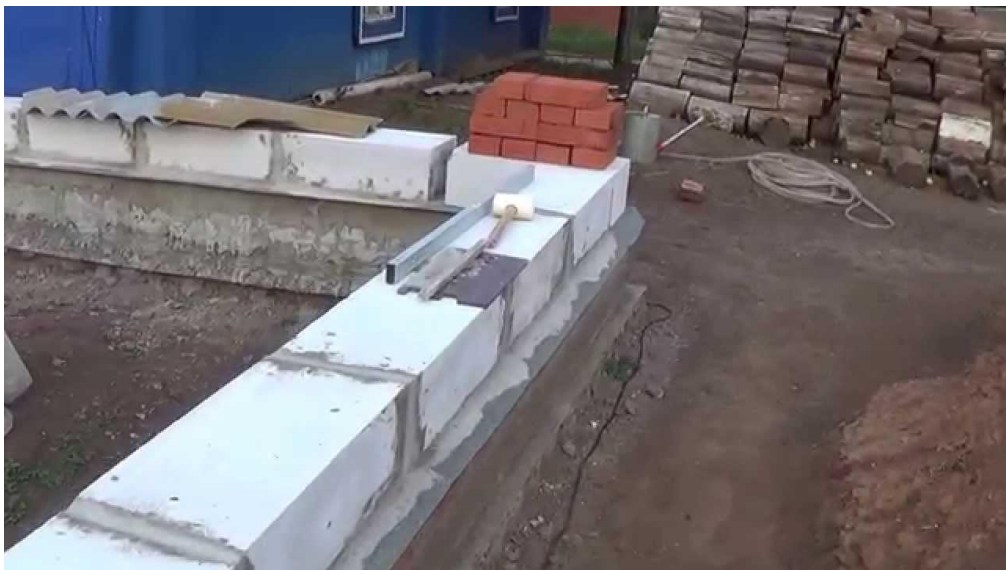
Рисунок 2.6 - Укладанням першого ряду блоків
