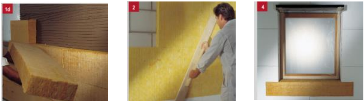
Рисунок 2.13 – Приклеювання теплоізоляційних плит до основи
