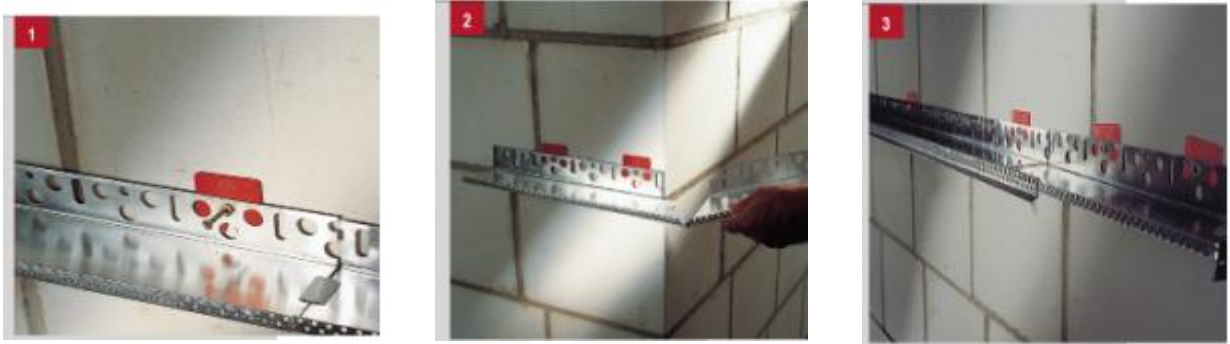
Рисунок 2.11 – Встановлення кріплення цокольного профілю
