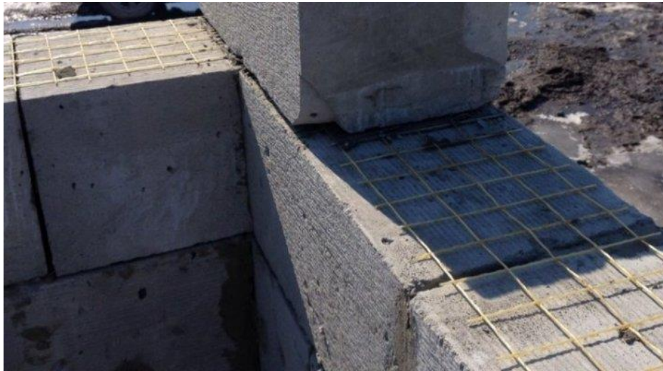
Рисунок 2.7 – Армуння кладки
