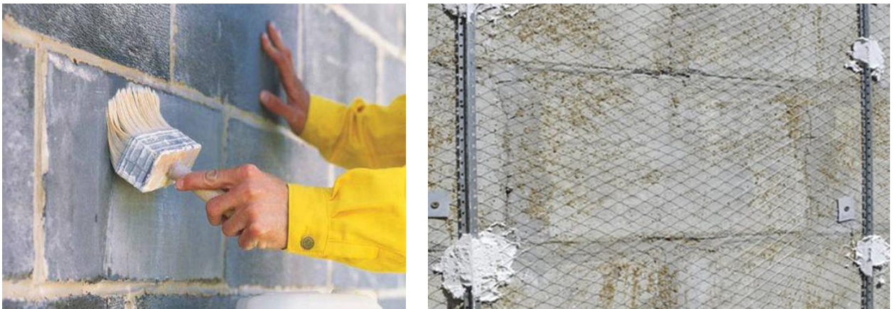
Рисунок 2.9 – Нанесення ґрунтовки та штукатурної сітки
