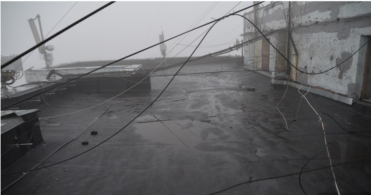
Рисунок 2.2 – Фотографія покрівлі будівлі
