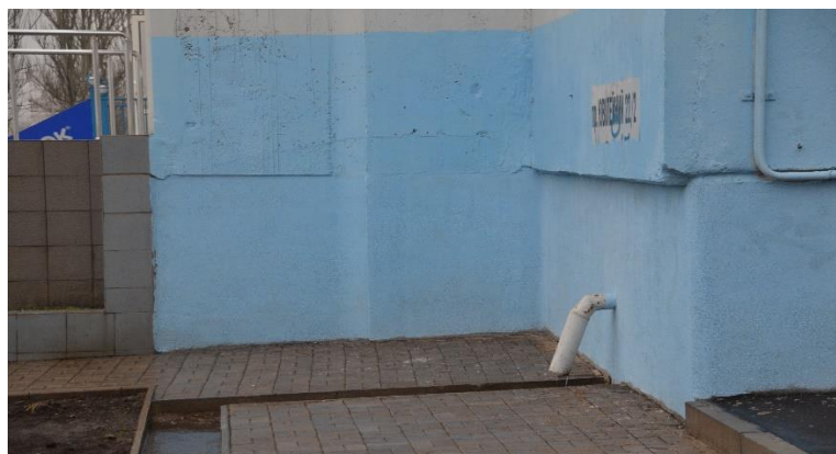
Рисунок 2.3 – Фотографія цокольної частини будівлі
