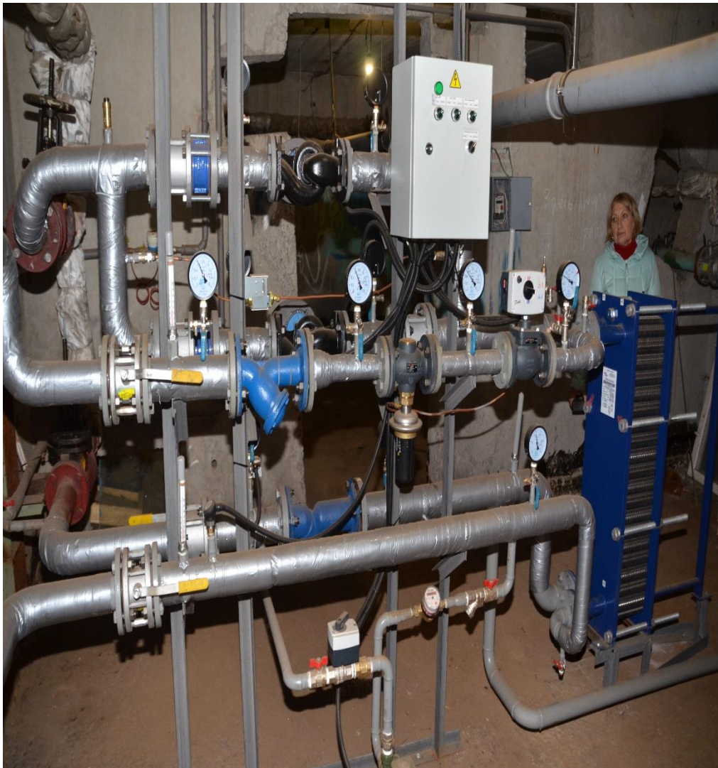
Рисунок 2.4 – Фотографія цокольної частини будівлі
