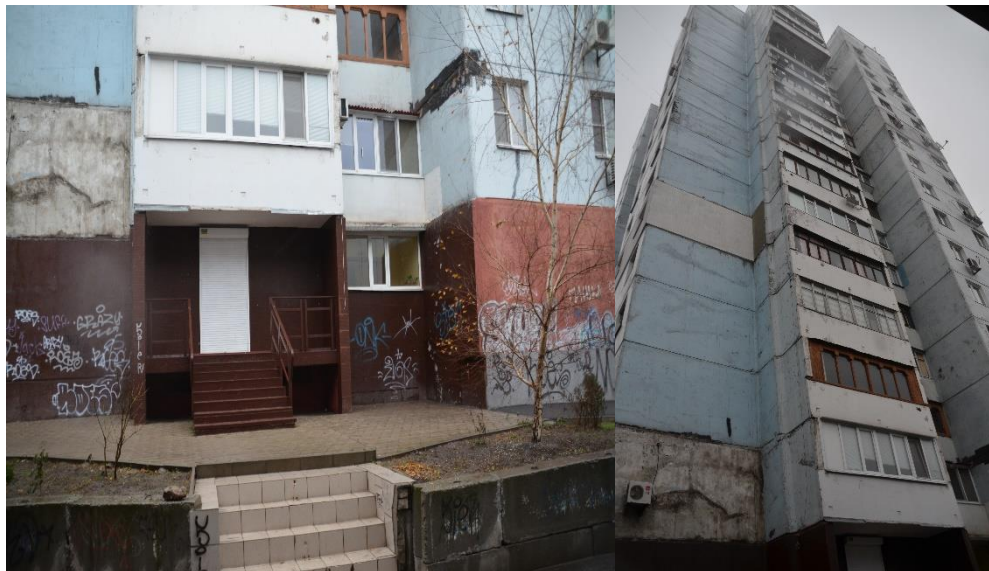
Рисунок 2.1 – Фотографія стін будівлі
