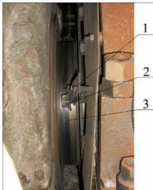
Рисунок 1.2 – Заземлювальний пристрій турбогенератора
