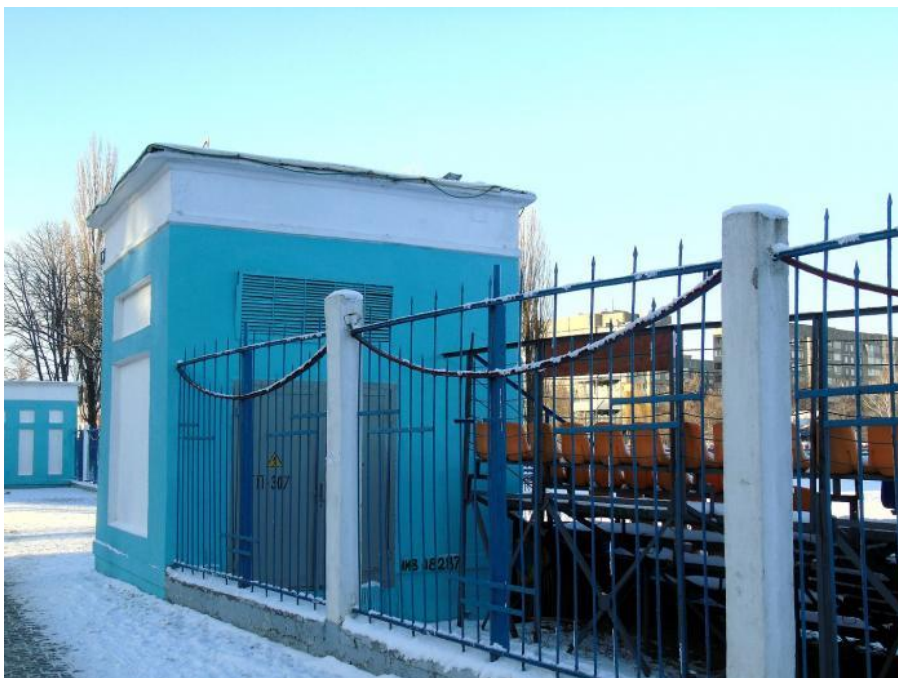
Рисунок 1.2 – Трансформаторна підстанція ТП 307
