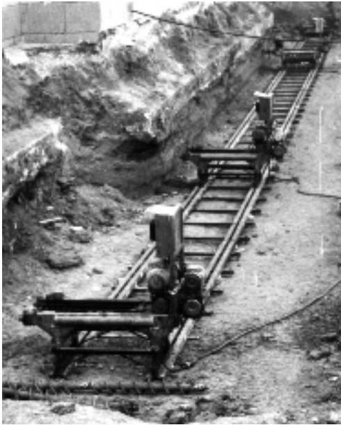
Рис. 3.6. Розміщення станків на рейкових напрямних
