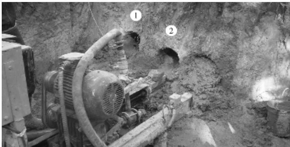
Рис.3.13. Пройдені свердловини бурозмішувачами: 1 – однолопатевою („старою”) конструкцією; 2 - трьохлопатевою („новою”) конструкцією
