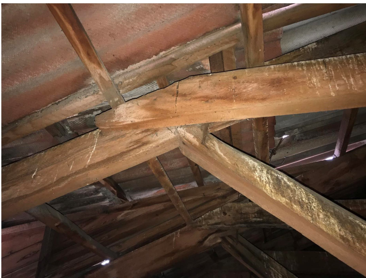
Рисунок 2.26 – Технічний стан решетування і листів АЦВ.
