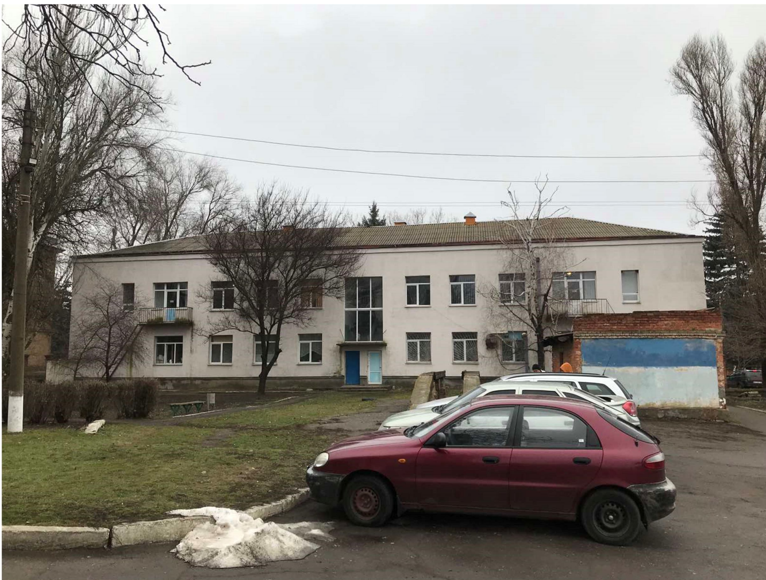
Рисунок 2.3 – Загальний вид будівлі зі сторони дворового фасаду.
