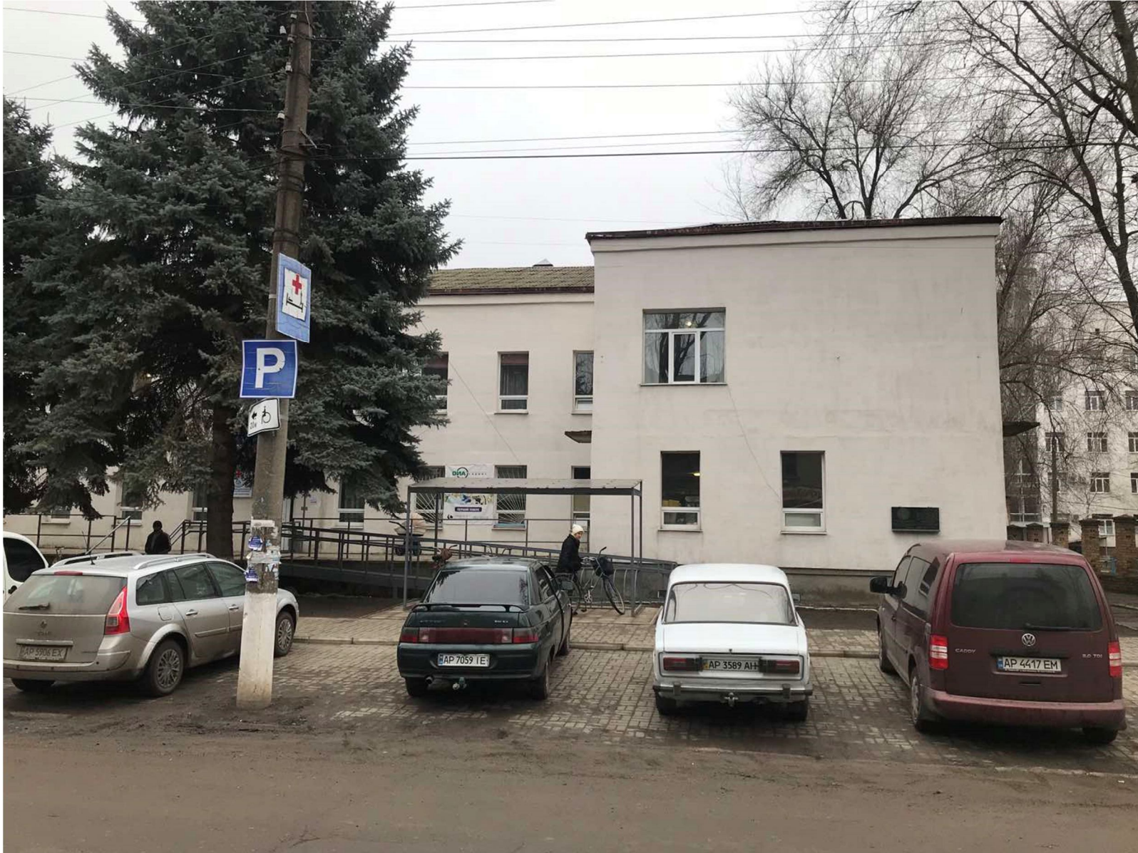
Рисунок 2.1 – Загальний вид будівлі зі сторони головного фасаду
