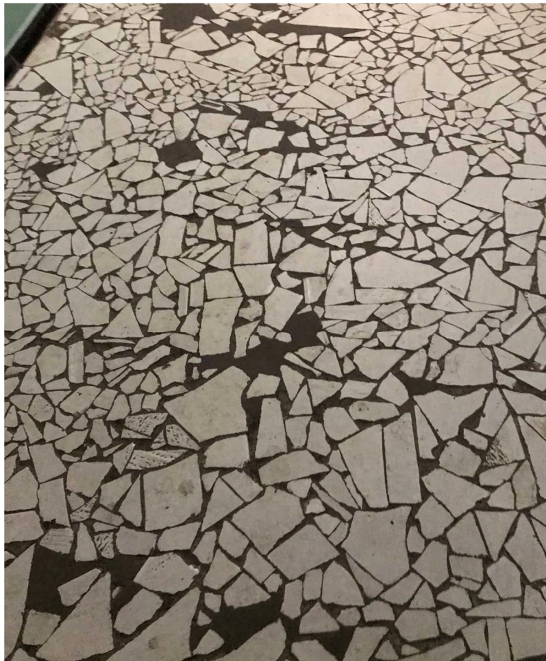
Рисунок 2.20 – Технічний стан підлоги із уламків керамічних плиток.
