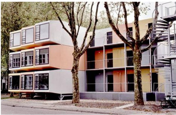
Рисунок 1.5 – Приклад використання об'ємно-блочної конструктивної системи при будівництві гуртожитку та житлового будинку.
