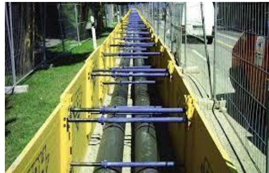
Рисунок 1.5 - Інвентарне металеве кріплення: 1 - трубчаста стійка; 2 - розпірка; 3 - муфта; 4 - розвідний гвинт; 5 - дошки огорожі; 6 - дно траншеї; 7 - ґрунт з траншеї; 8 - брівка траншеї
