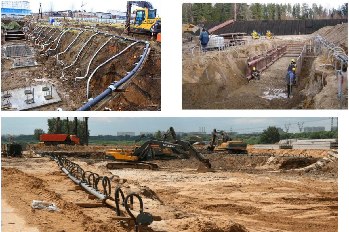
Рисунок 1.3 – Голкофільтровий спосіб зниження рівня ґрунтових вод.
