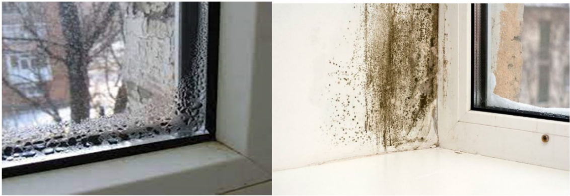
Рисунок 2.4 - Теплова відмова (утворення плісняви та підвищена вологість) після заміни дерев'яних вікон на металопластикові
