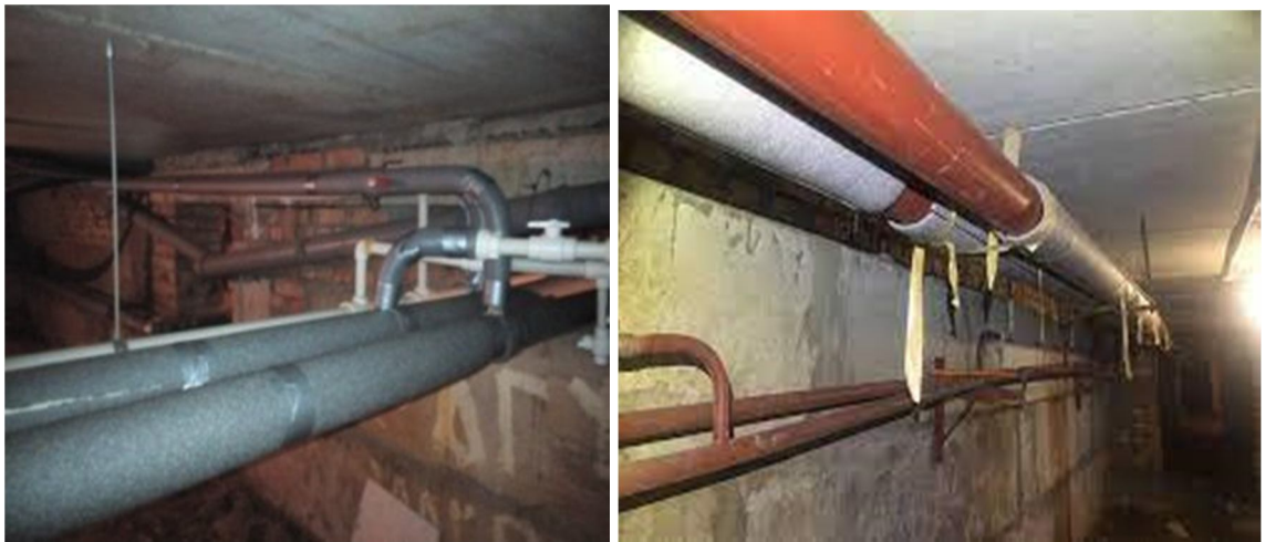
Рисунок 1.10 - Утеплення магістральних трубопроводів
