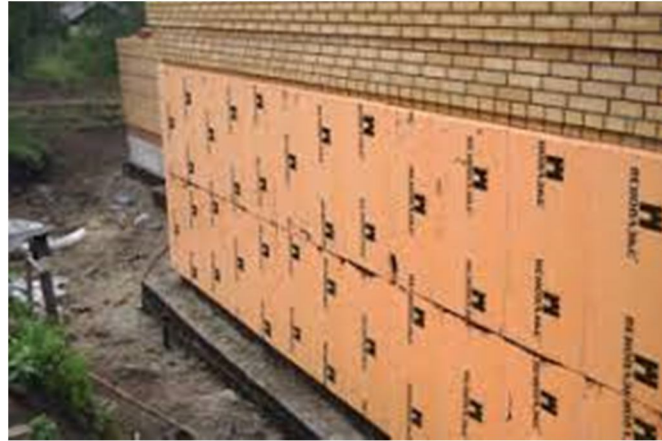
Рисунок 1.5 - Утеплення цоколю будівлі
