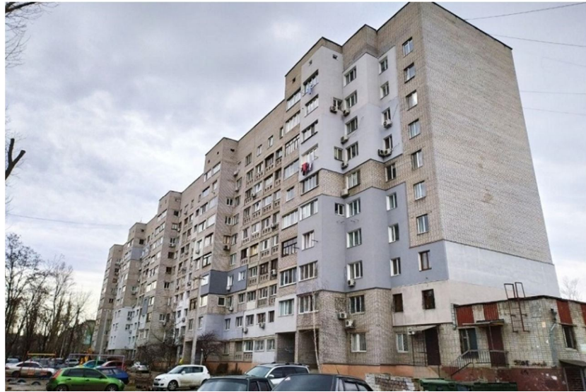
Рисунок 2.3 - Часткова (клаптикова) термореконструкція старих будинків
