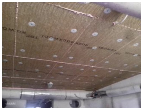
Рисунок 1.4 - Утеплення перекриття підвалу
