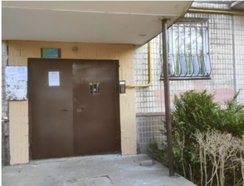
Рисунок 1.7 - Встановлення металевих дверей
