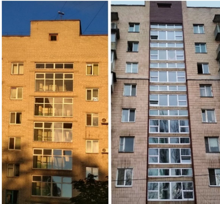
Рисунок 1.6 - Встановлення металопластикових вікон
