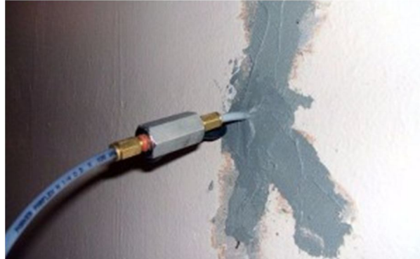
Рисунок 3.15 - Відновлення залізобетону шляхом ін'єктування
