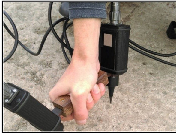
Рисунок 3.8 - Визначення міцності бетону конструкцій перекриттів неруйнівним методом з використанням ультразвукового сканера.
