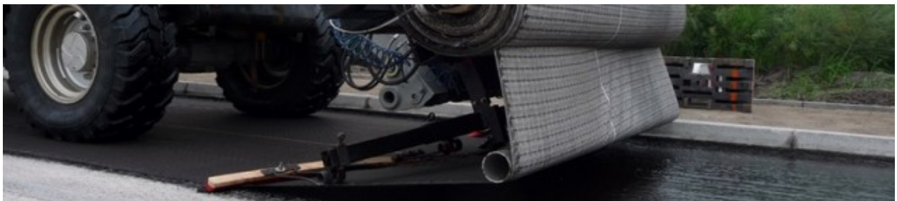
Рисунок 1.6 – Укладання сітки в асфальт
