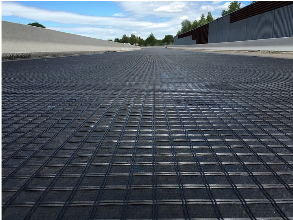
Рисунок 1.2 – Армування асфальтобетону синтетичними сітками
