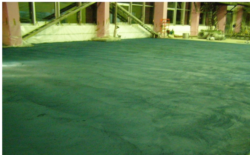
Рисунок 4.4 – Поверхня підлоги після проходу двороторної затиральної машини: виникнення хвилястості підлоги
