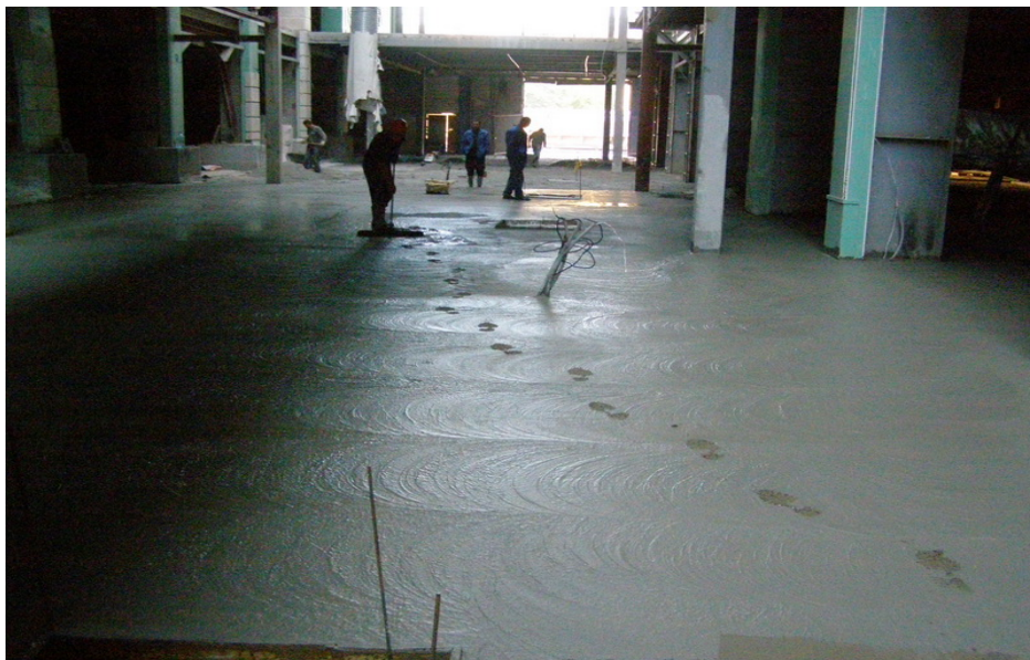
Рисунок 4.2 – Поверхня підлоги після проходу однороторної затиральної машини: виникнення хвилястості підлоги
