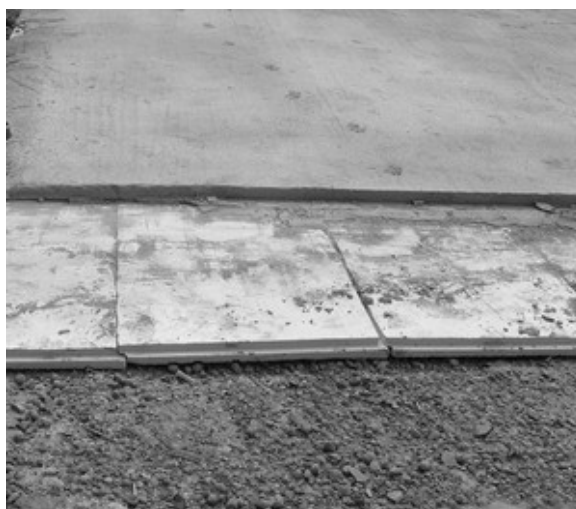
Рисунок 2.13 – Теплоізоляція підлоги за допомогою екструдированного пінополістиролу
