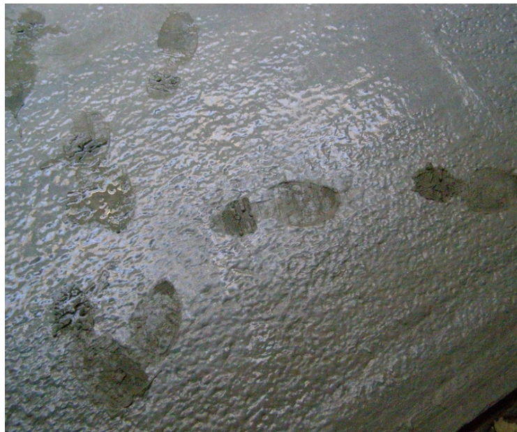
Рисунок 3.1 – Характерні відбитки сліду взуття робітника на бетонній поверхні як сигнал до початку затиральних робіт
