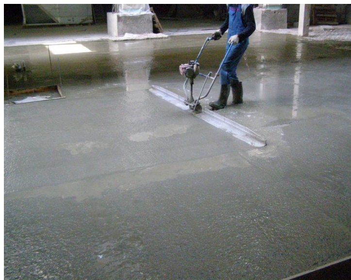
Рисунок 4.8 – Ущільнення бетонної суміші за допомогою віброрейки
