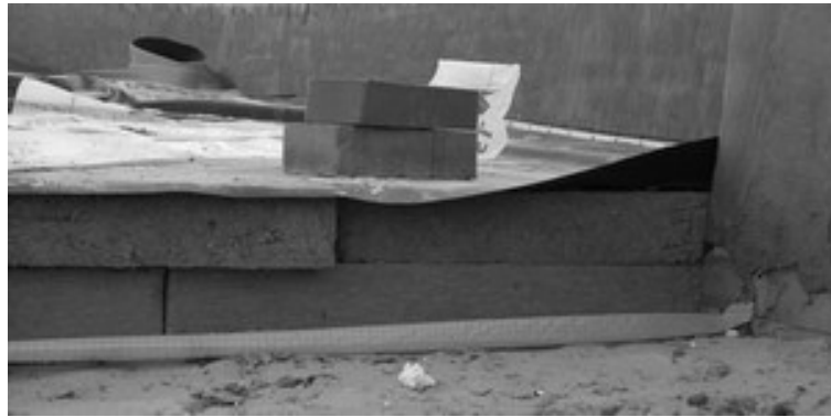
Рисунок 2.12 – Теплоізоляція підлоги за допомогою мінераловатного утеплювача
