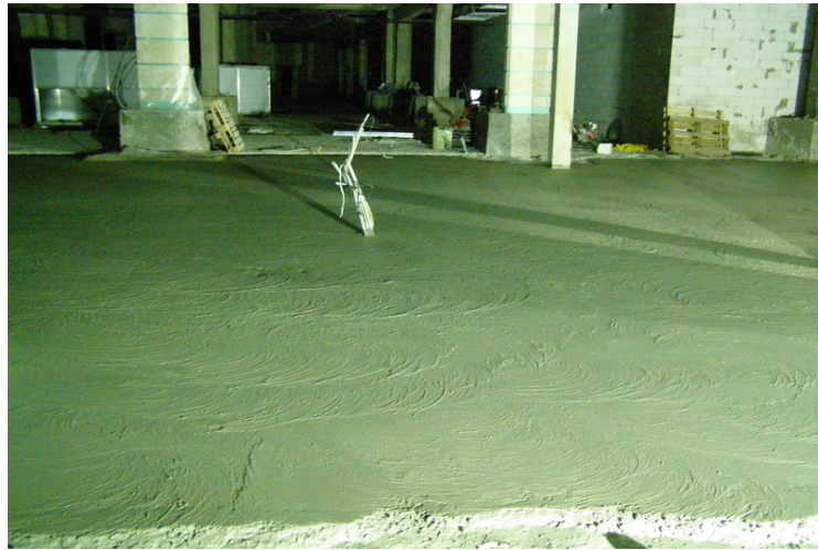
Рисунок 4.3 – Поверхня підлоги після проходу однороторної затиральної машини: виникнення хвилястості підлоги й напливів
