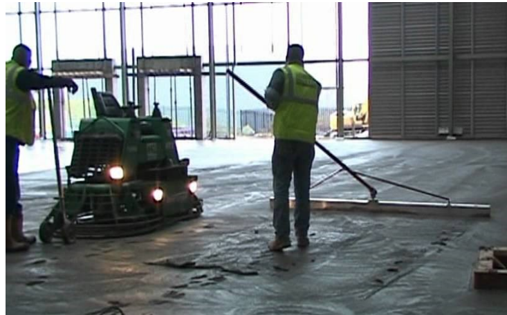
Рисунок 4.13 – Робота гладилкою для зрізання нерівностей
