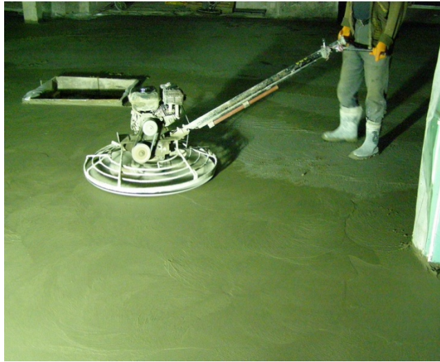
Рисунок 4.15 – Процес затирання однороторною затиральною машиною
