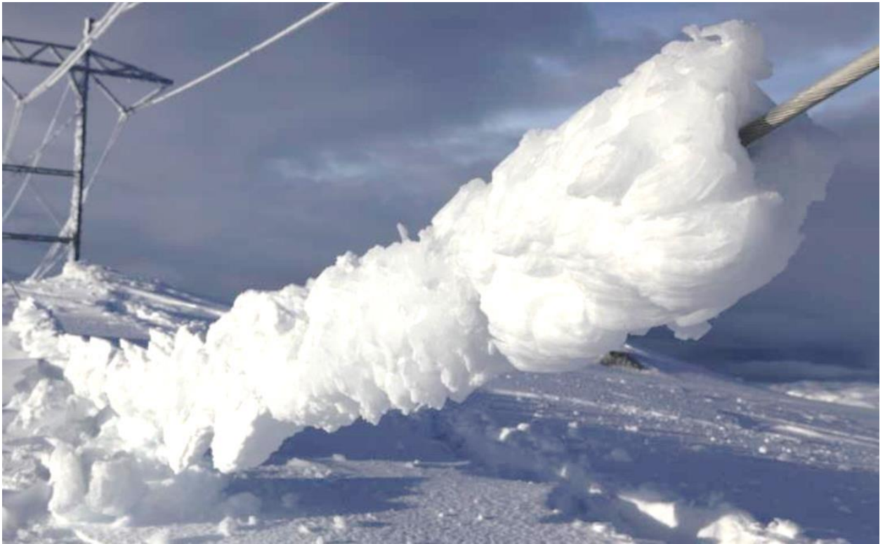
Рисунок 1.2 – Відкладення морозу на алюмінієвому дроті показано білим шаром
