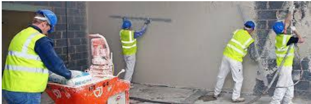
Рисунок 1.24 – Внутрішнє облицювання штукатурки стін з використанням механізмів
