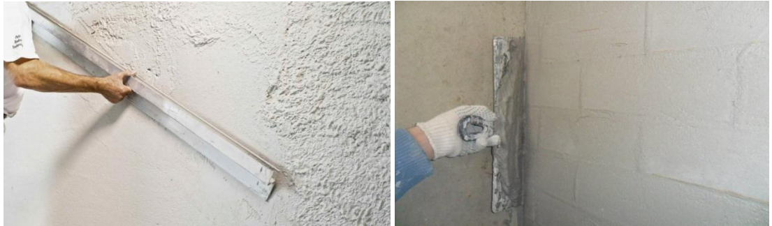
Рисунок 1.9 – Вирівнювання штукатурки;
