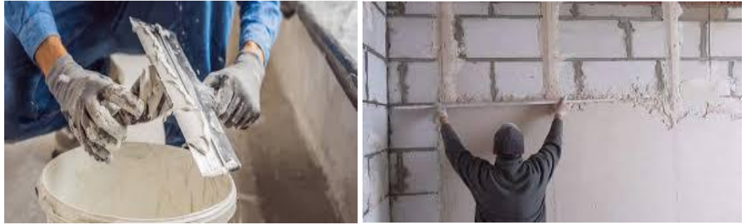
Рисунок 1.8 – Приготування та нанесення цієї суміші;
