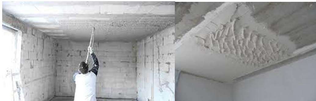
Рисунок 1.25 – Внутрішнє облицювання штукатурки стелі з використанням механізмів
