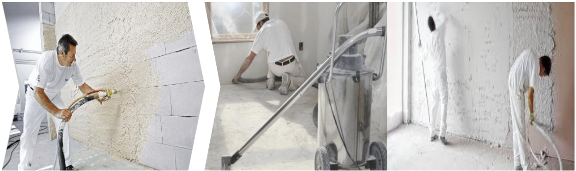
Рисунок 1.26 – Облицювання штукатурки з використанням механізмів
