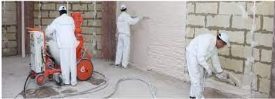
Рисунок 1.21 – Штукатурна станція та розчино-змішувальні насоси фірми KALETA
