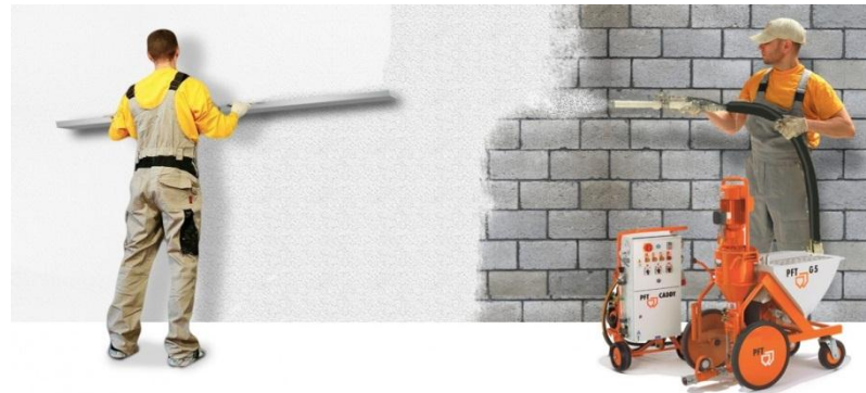
Рисунок 1.14 — Приклад за допомогою штукатурних станцій ( а)
