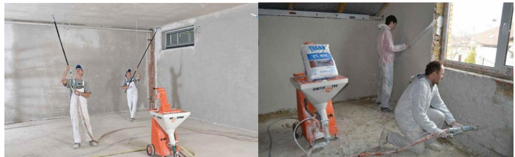
Рисунок 1.16 – Приклад виконання машинної штукатурки стелі та підвіконня (б)
