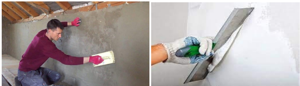
Рисунок 1.10 – Затирання штукатурки та шпатлювання
