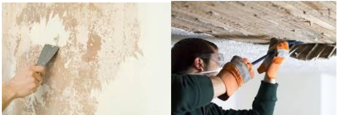
Рисунок 1.6 – Очищення стіни під штукатурку;
