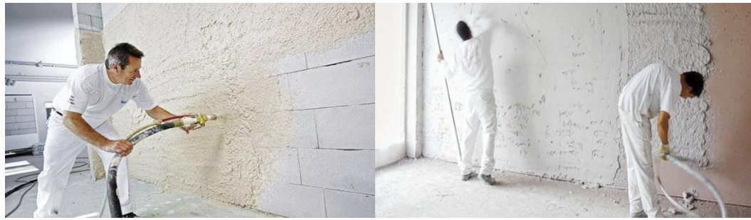
Рисунок 1.16 – Виконання машинної штукатурки покриття стін (б)
