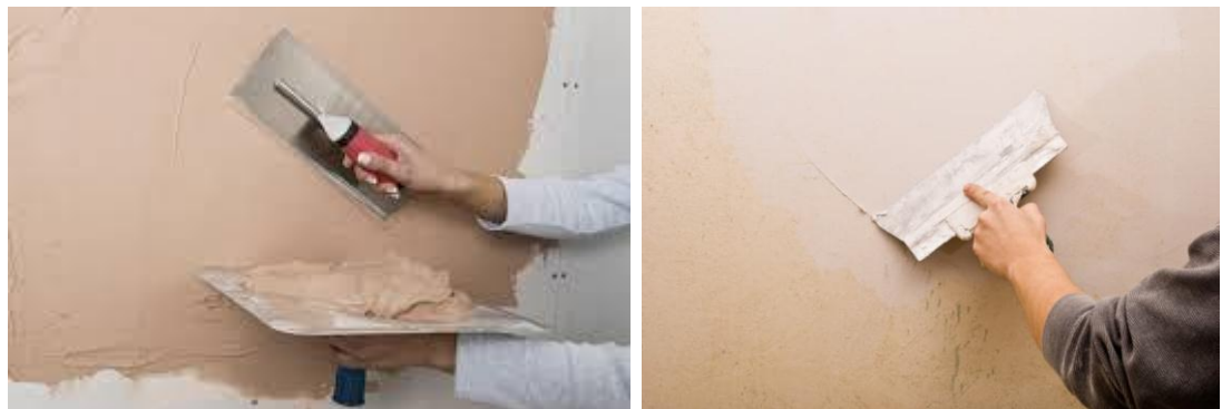
Рисунок 1.4 – Приклад виконання «сухої» штукатурки
