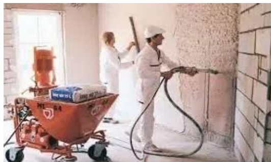
Рисунок 1.16 – Приклад виконання машинної штукатурки (а)
