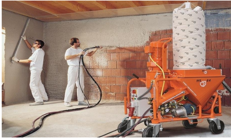
Рисунок 1.27– Механізований метод з використанням штукатурної станції Кнауф PFT G4,
