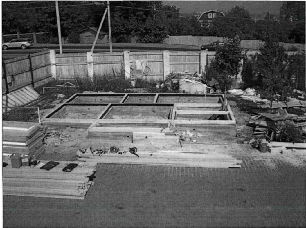
Рисунок 3.9 – Влаштування стрічкового бетонного фундаменту під експериментальний котедж
