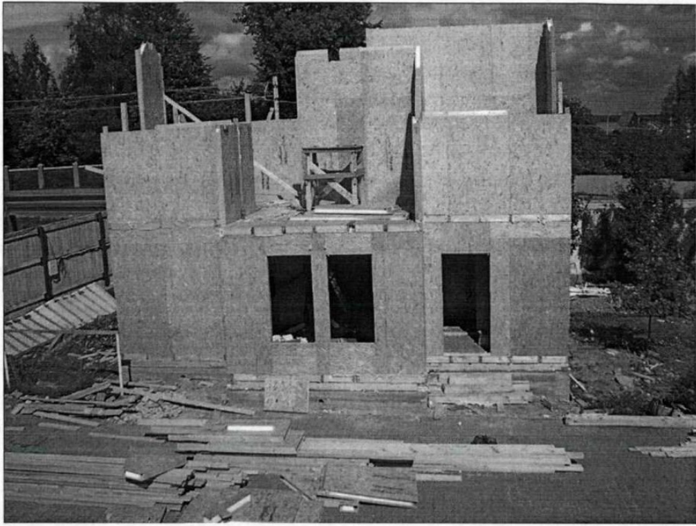
Рисунок 3.13 – Установка панелей перегородок із сендвіч-панелей
