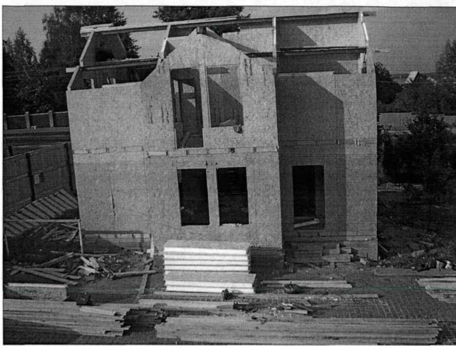
Рисунок 3.15 – Влаштування даху та кровлі
