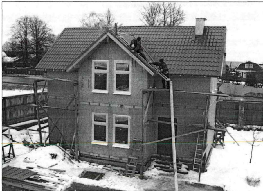
Рисунок 3.16 – Зовнішнє оздоблення котеджу, зведеного за експериментальною технологією з швидкозбірних сендвіч-панелей
