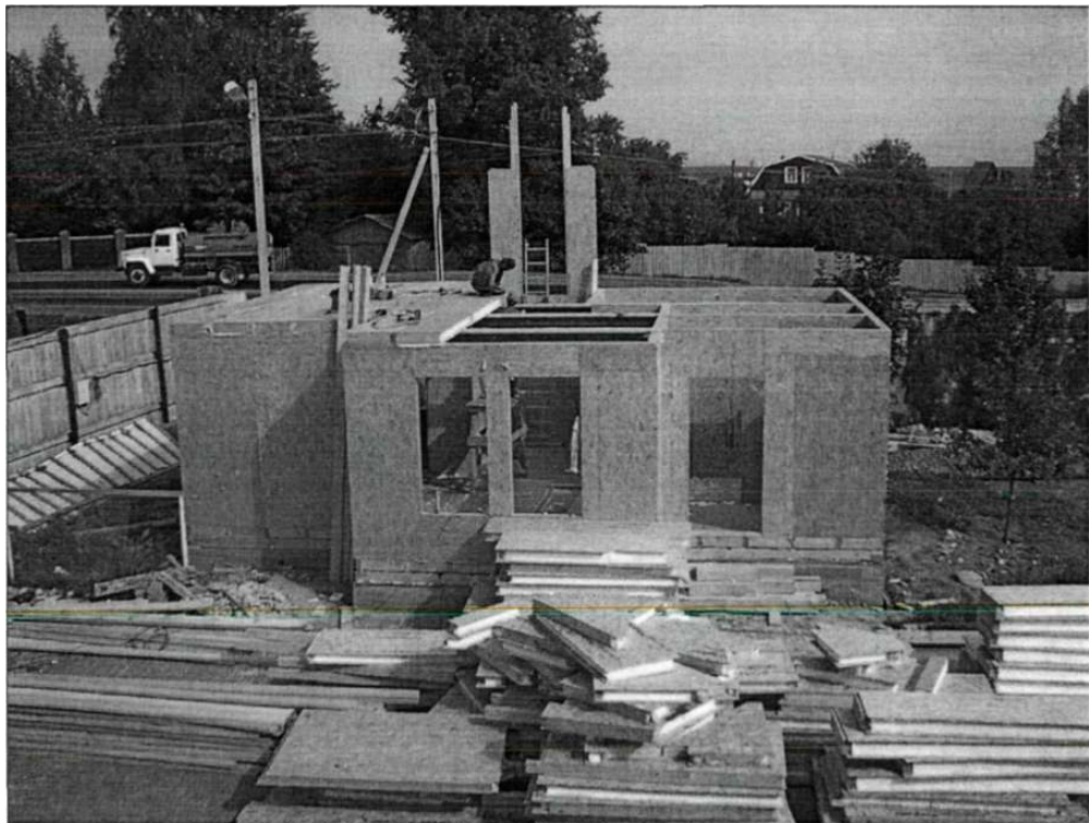
Рисунок 3.12 – Установка зовнішніх стінових панелей 2 поверху з сендвіч-панелей
