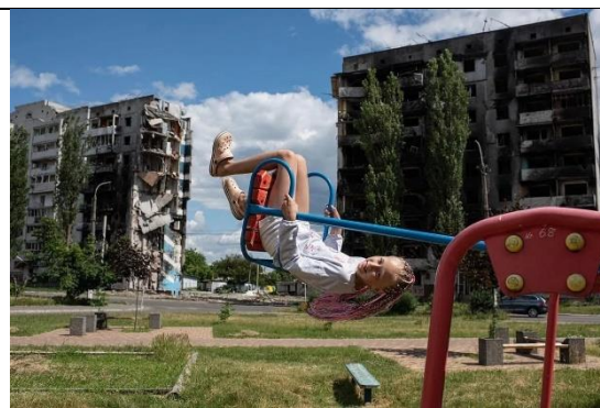
Фото: Alexey Furman / Getty Images дівчинки на гойдалці на тлі зруйнованого будинку
