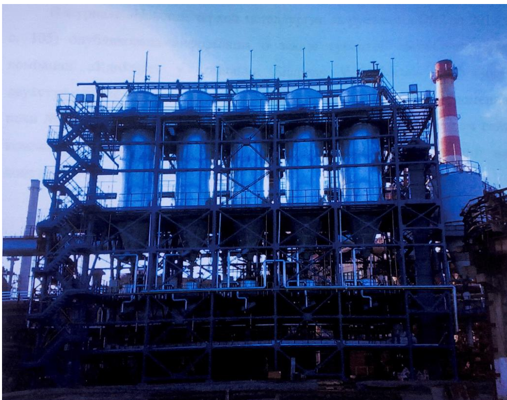
Рисунок 1.17 – Загальний вид газоочищення доменної печі з рукавним фільтром в умовах ВАТ «Косогірський металургійний комбінат»
