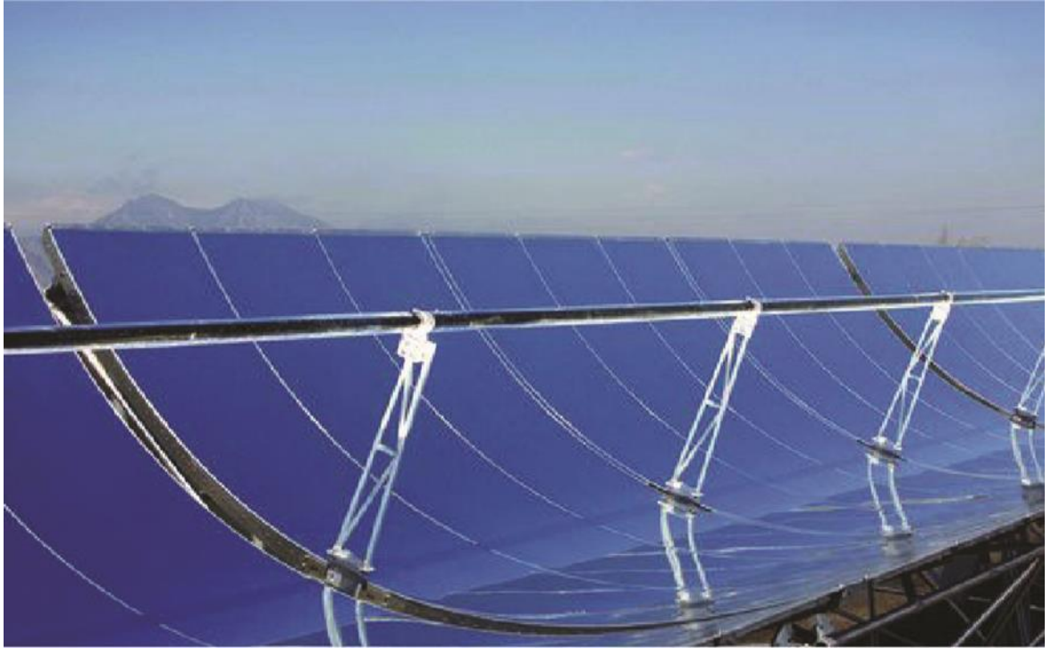
Рисунок А.3 – Параболоциліндричні колектори
