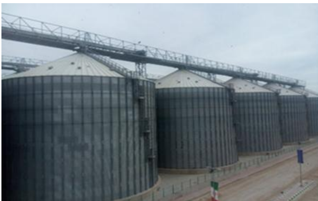
А. 4 – Металеві силоси з оцинкованої сталі
