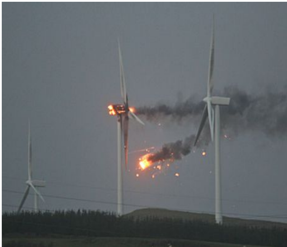
Рисунок 6.2 – Аварія вітрогенератора з ротором на сталих магнітах
