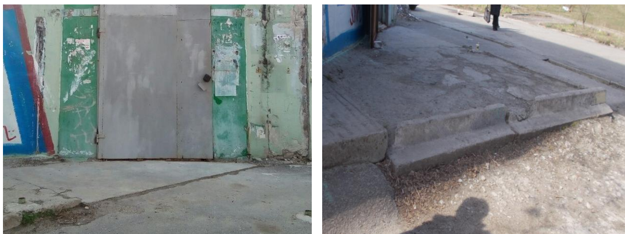
Рисунок 1.6 – Фрагмент пошкодження ганку
