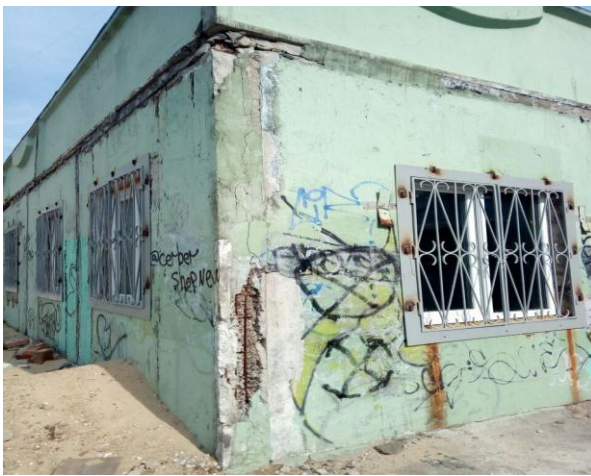
Рисунок 1.3 – Фрагмент пошкодження зовнішніх стін
