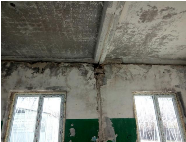
Рисунок 1.4 – Фрагмент пошкодження примикання стін до плит перекриття
