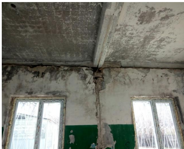
Рисунок 1.8 – Фрагмент пошкодження стін та стелі
