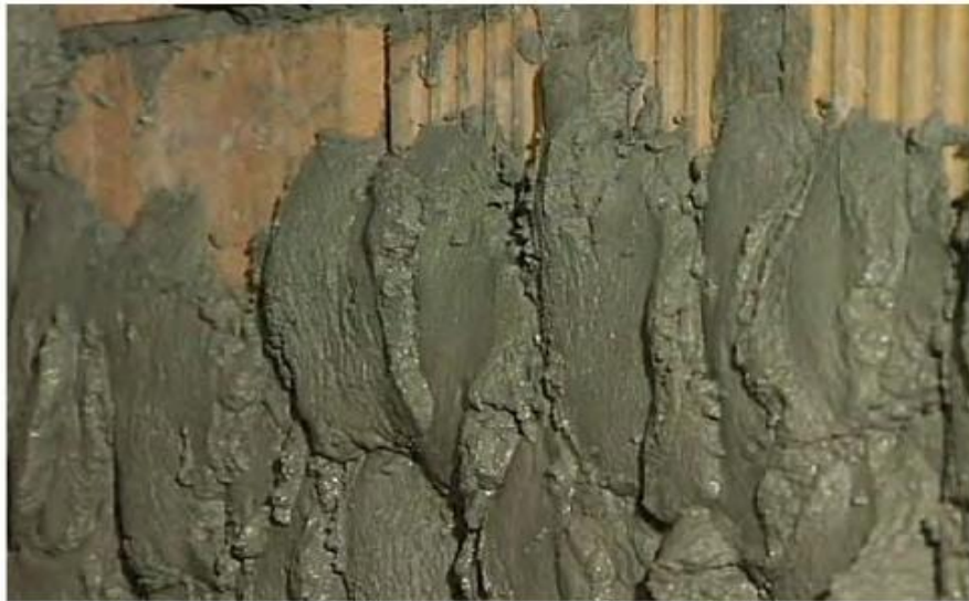
Рисунок 3.4 - Фрагмент «накидування»
