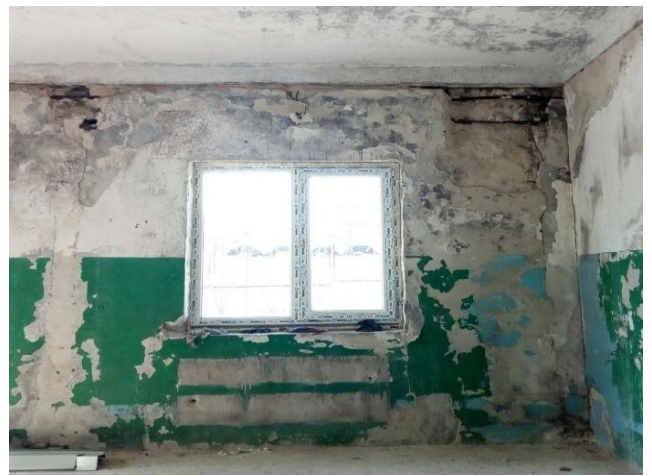
Рисунок 1.3 – Фрагмент пошкодження зовнішніх стін
