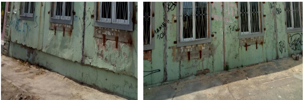
Рисунок 1.2 – Фрагменти вимощення навколо будівлі
