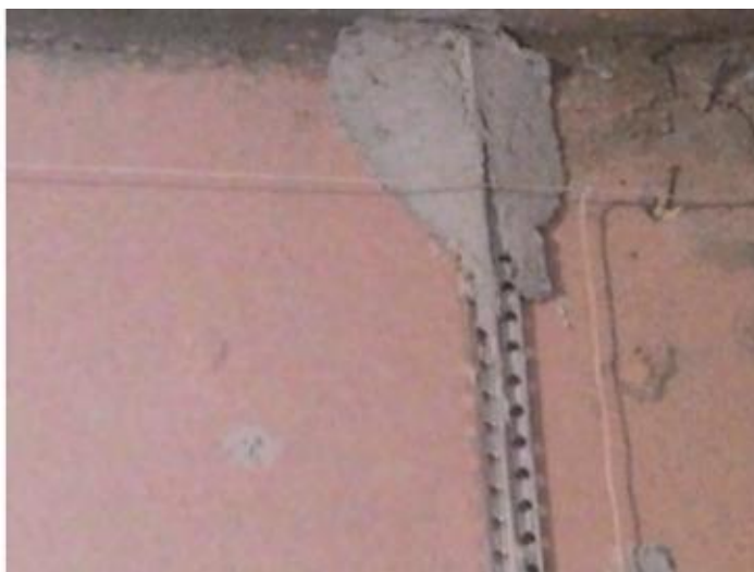
Рисунок 3.11 - Після висихання "марок" потрібно заповнити розчином проміжки між маяком та стіною.
