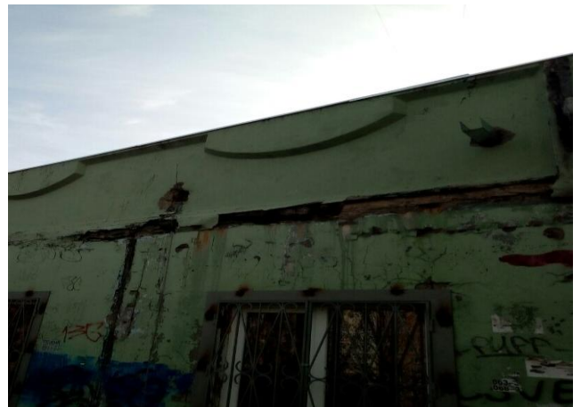
Рисунок 1.4 – Фрагмент пошкодження примикання стін до плит перекриття
