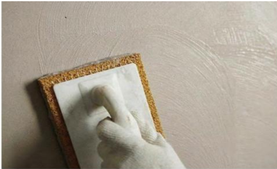
Рисунок 3.7. - Фрагмент затирання
