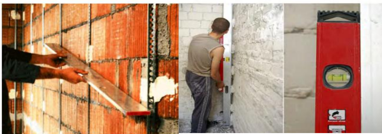
Рисунок 3.10 - Металевий маяк прикладається до цих марок і притискається рівнем вертикально. З допомогою натиску на маяк можна регулювати його положення по відношенню до потрібного рівня
