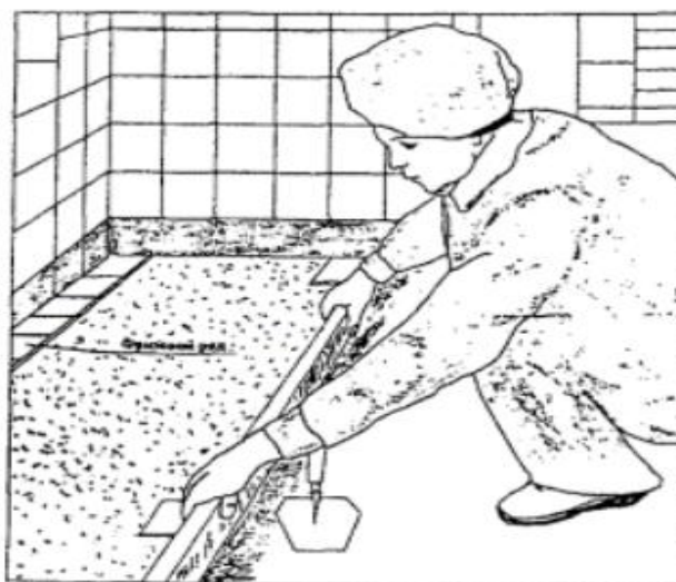
Рисунок 3.18 - Розрівнювання розчину рейками по маякам
