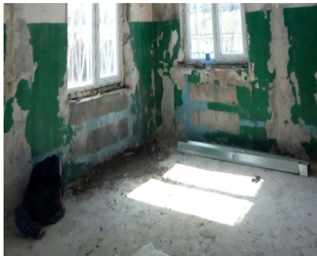
Рисунок 1.9 – Фрагмент відшарування фарбування
