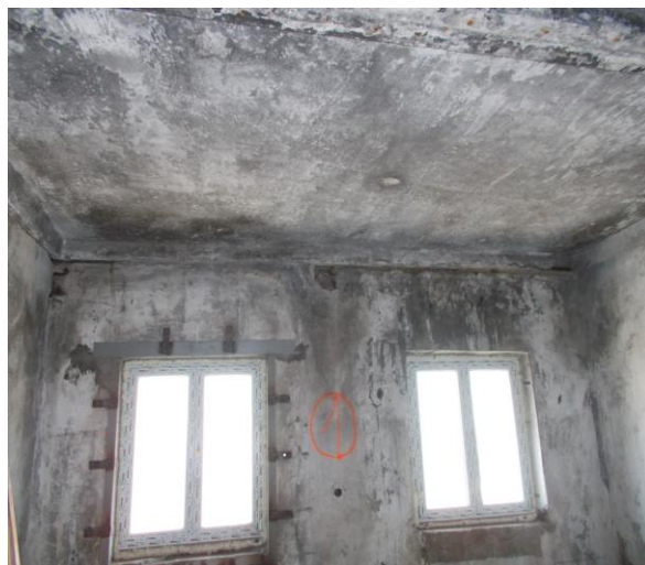
Рисунок 1.8 – Фрагмент пошкодження стін та стелі
