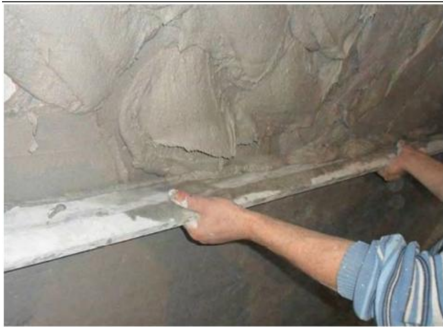
Рисунок 3.5 - Фрагмент нанесення ґрунту
