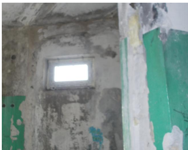
Рисунок 1.9 – Фрагмент відшарування фарбування
