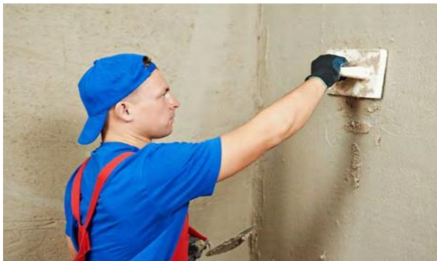
Рисунок 3.6. - Фрагмент накривки
