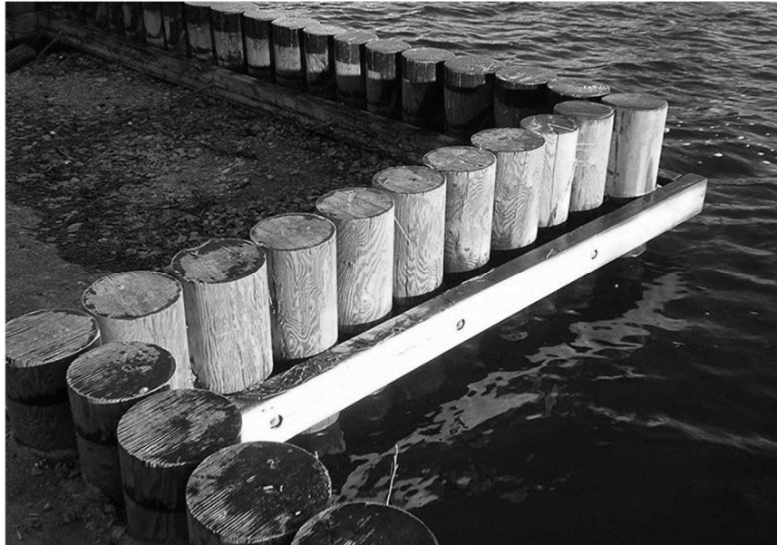
Рисунок 1.8 – Укріплення дерев'яними палями
