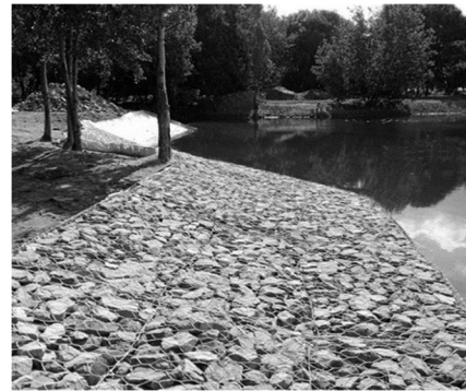
Рисунок 1.6 – Укріплення габіонами та матрацами
