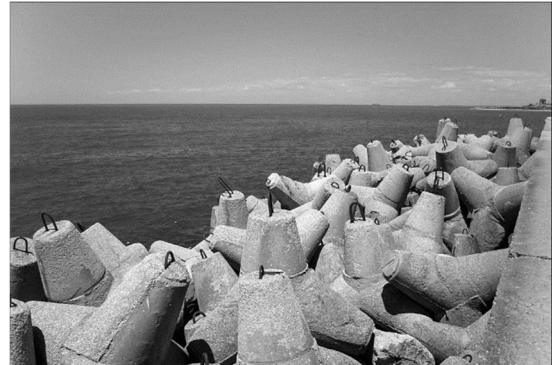
Рисунок 1.5 – Укріплення крупними блоками і фігурними масивами
