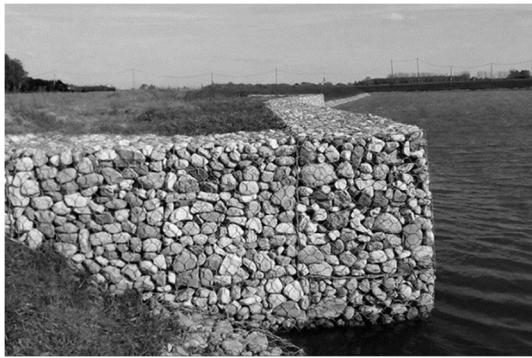
Рисунок 1.6 – Укріплення габіонами та матрацами
