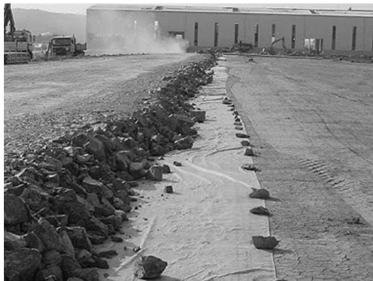
Рисунок 4.4 – Настил із геотекстилю
