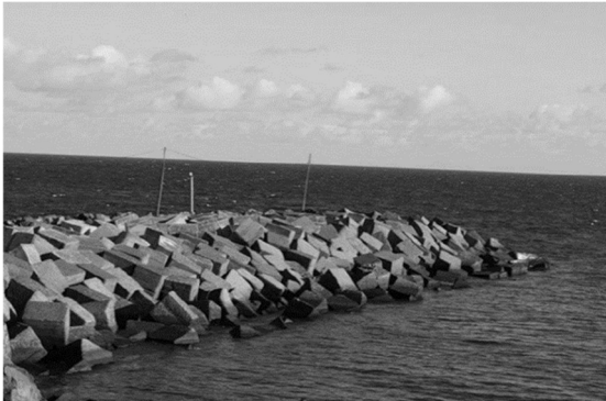
Рисунок 1.5 – Укріплення крупними блоками і фігурними масивами
