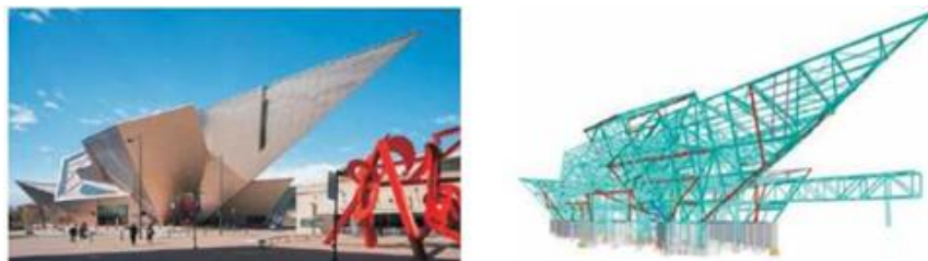
Рисунок 1.4 – ВІМ сталевого каркасу та фасад Музею мистецтв у Денвері, США, арх. бюро D. Libeskind, 2006 р
