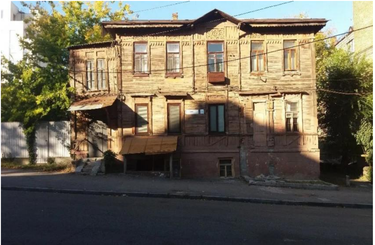
Рисунок 2.12- Дерев'яний будинок по Крутогірному узвозу, 5 м. Дніпро
