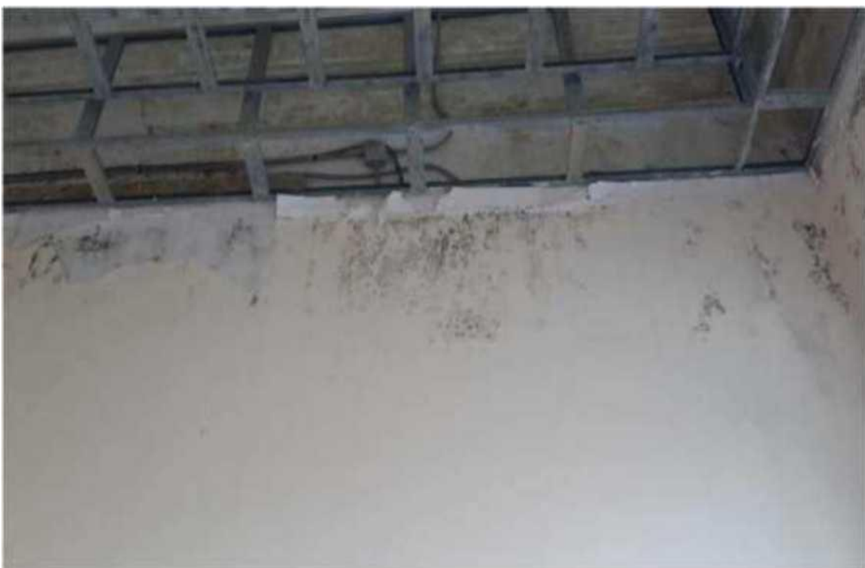
Рисунок 2.4 - Цвіль на стінах та перекриттях
