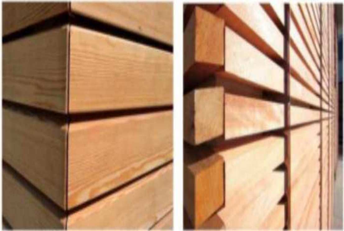
Рисунок 1.1 - Фасад досліджуваної будівлі
