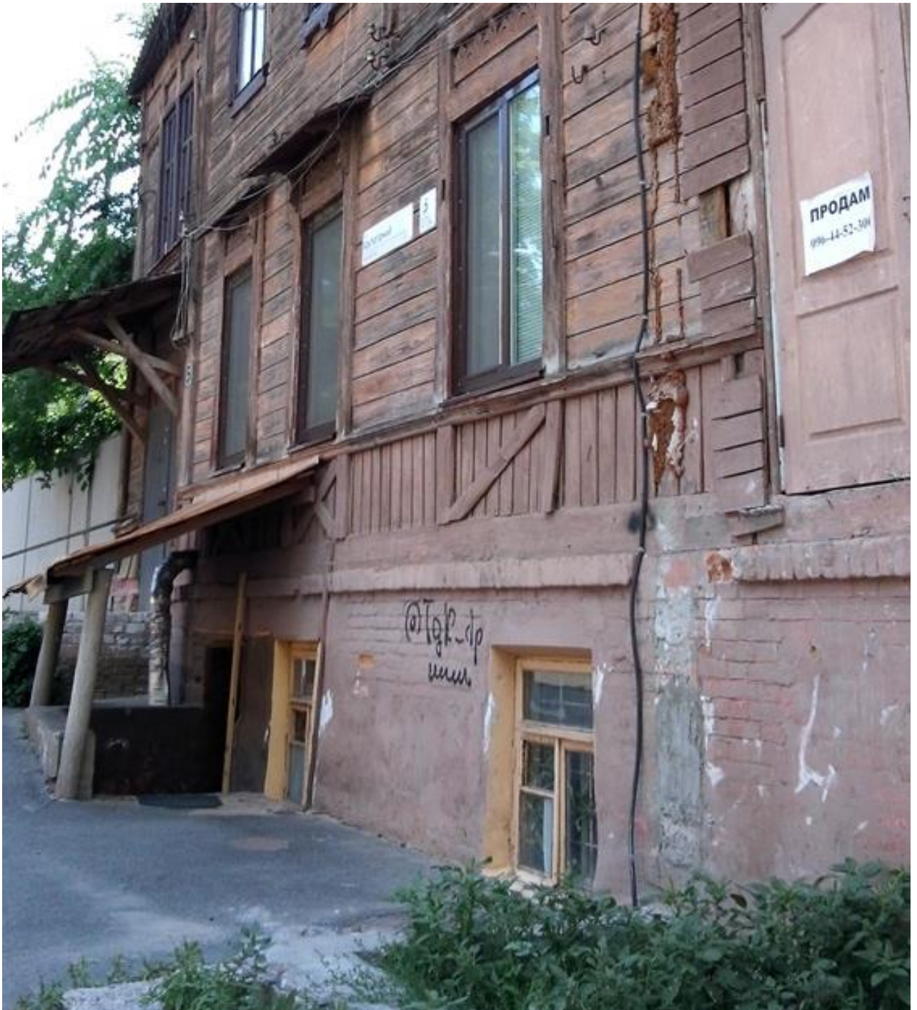
Рисунок 2.14 - Фундамент і отмостка будівлі
