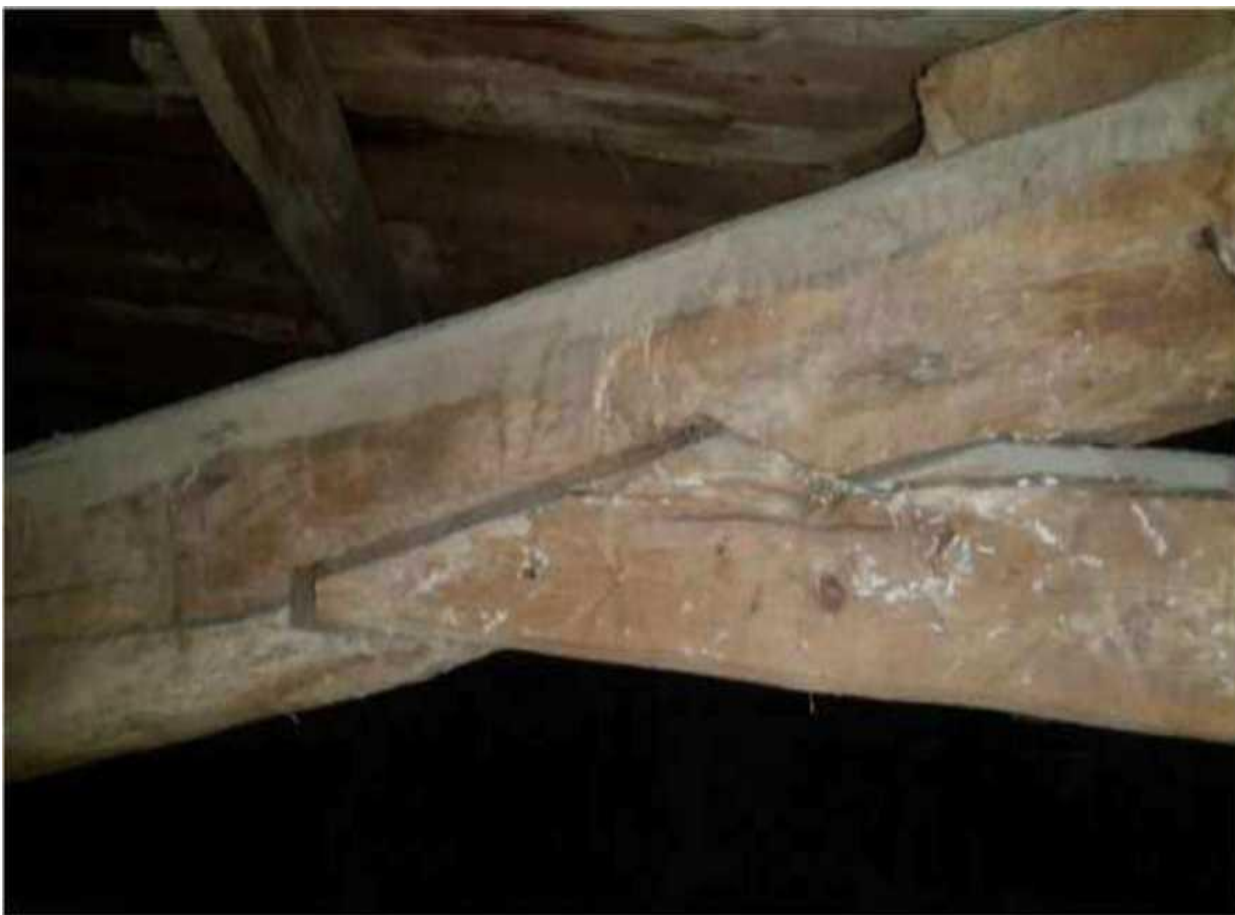
Рисунок 2.7 - Розлад вузлів кроквяної системи
