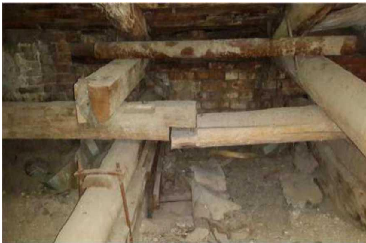
Рисунок 2.10 - Розлад вузлів кроквяної системи
