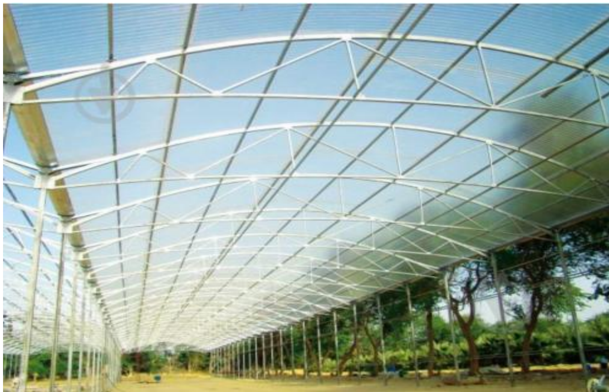
Рисунок 1.9 - Навіс із склопластика
