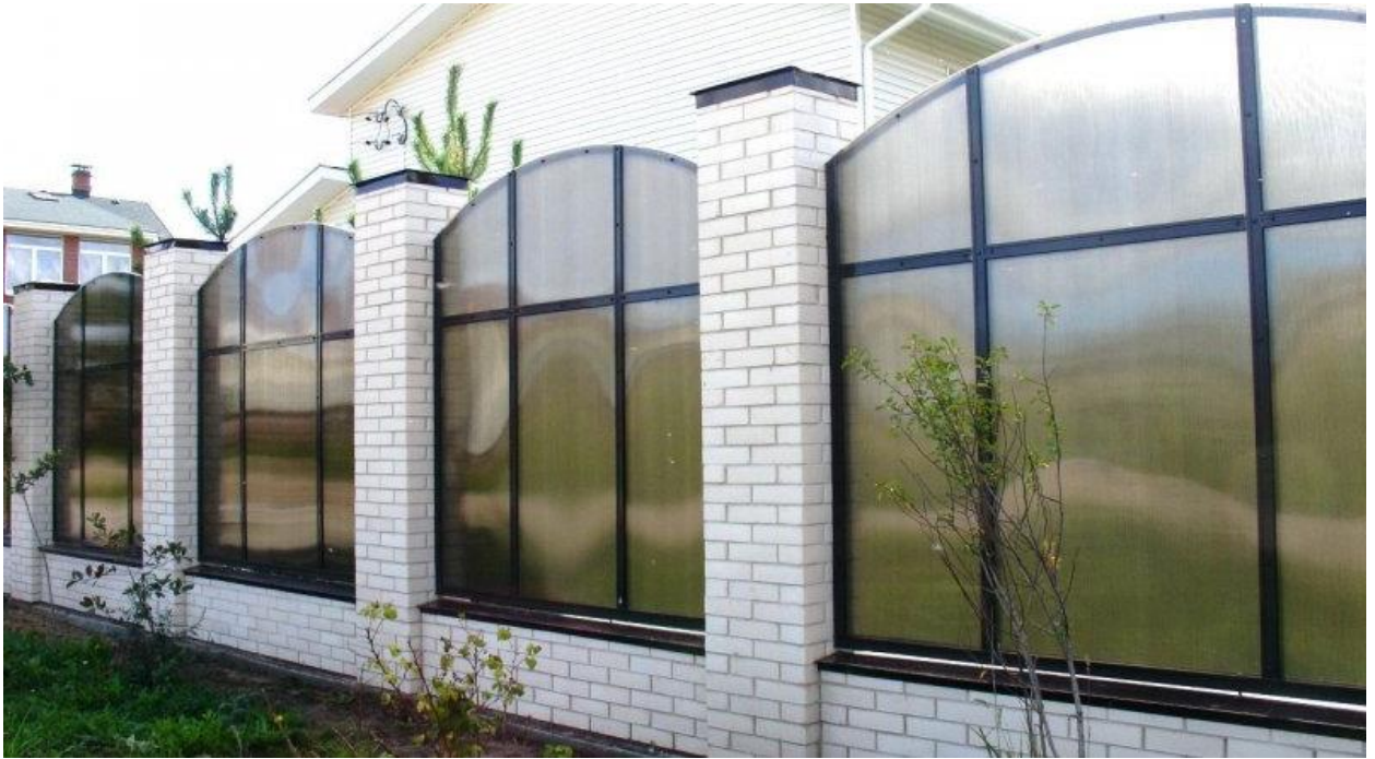
Рисунок 1.11 - Паркан із склопластика
