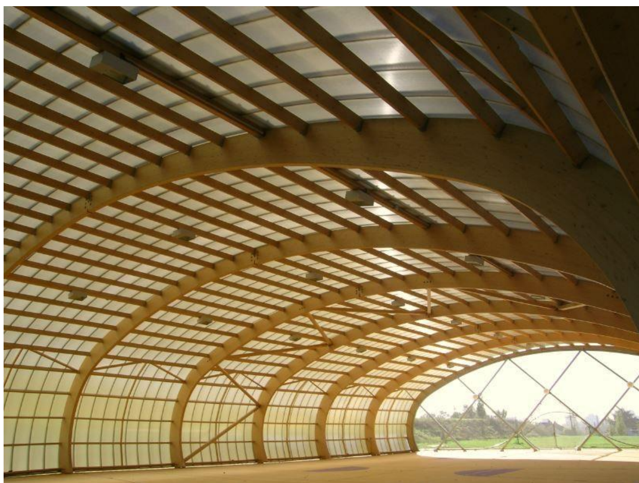
Рисунок 1.6 - Перекриття з полікарбонату
