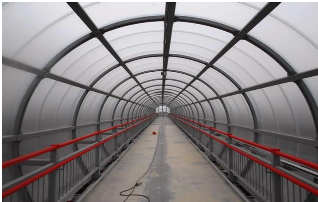
Рисунок 1.10 - Тунель із склопластика
