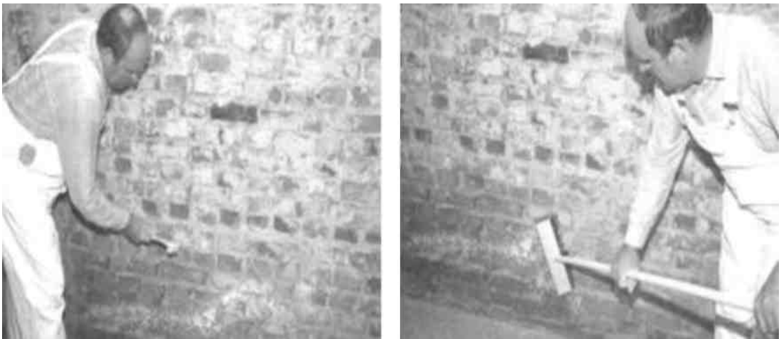
Рисунок 4.1 – Видалення нетривких ділянок гідроізолюємої поверхні
