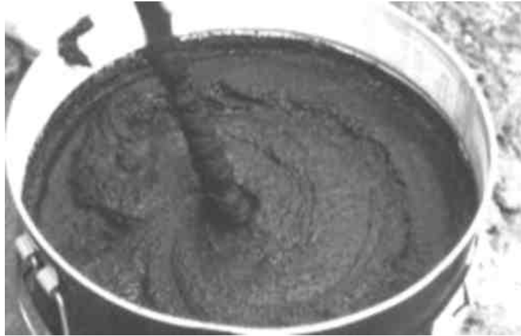
Рисунок 4.4 – Приготування розчинної суміші
