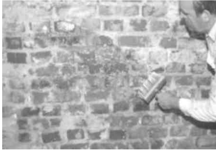
Рисунок 4.3 – Нанесення ґрунтовки за допомогою щітки
