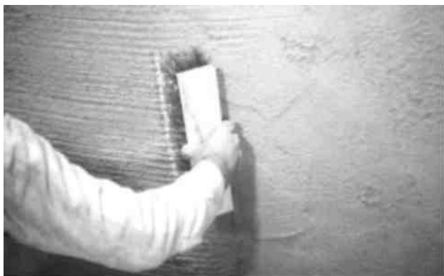
Рисунок 4.5. – Нанесення першого шару гідроізоляції
