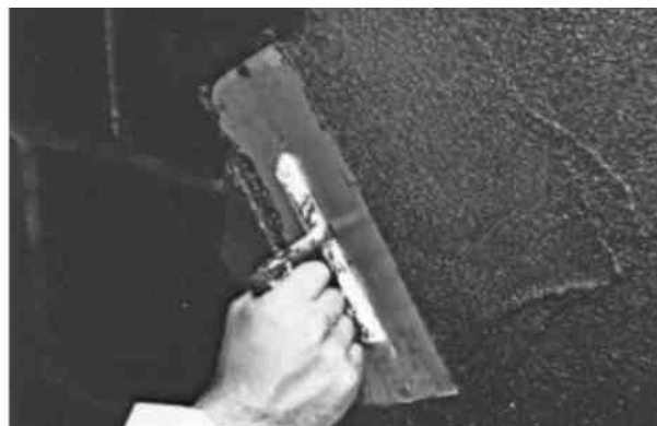
Рисунок 4.6 – Нанесення третього шару зольції
