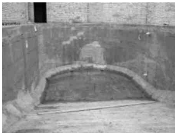
Рисунок 3.1 – Улаштування гідроізоляції
