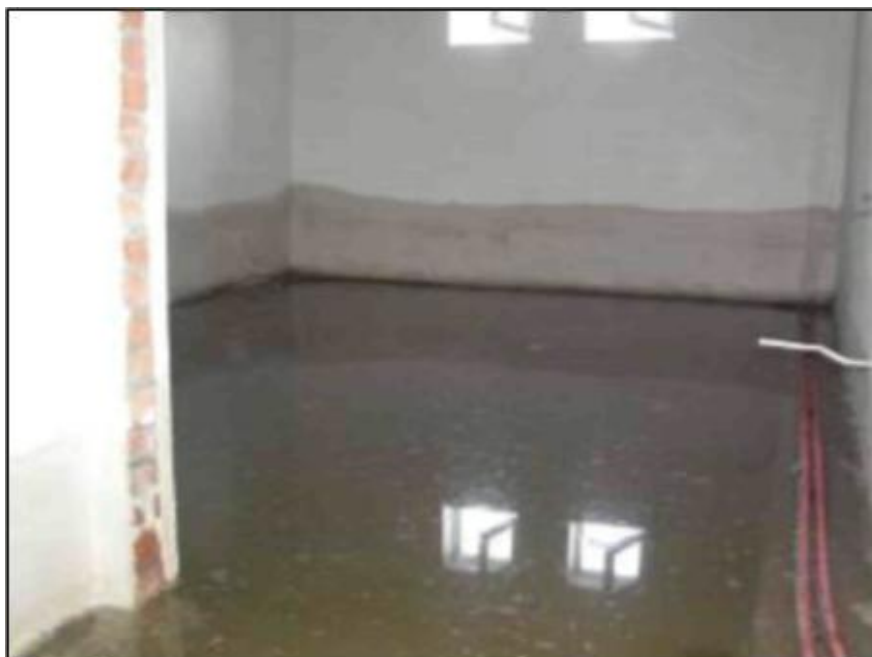
Рисунок 3.5 – «Відмова» роботи гідроізоляції через зміни водних навантажень
