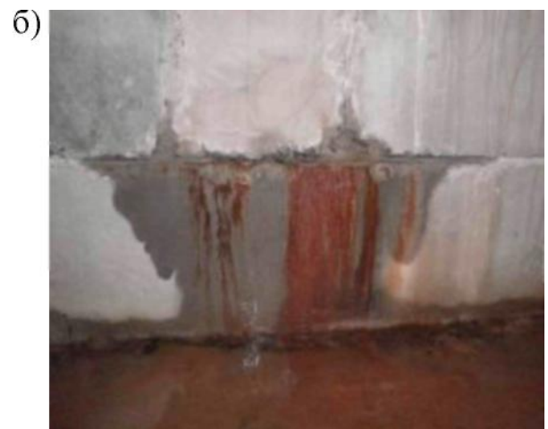
Рисунок.3.7 – «Відмова» роботи гідроізоляції внаслідок неправильно обраного шару гідроізоляції (а); порушення герметичності конструкції в результаті пошкодження гідроізоляційного шару (б)
