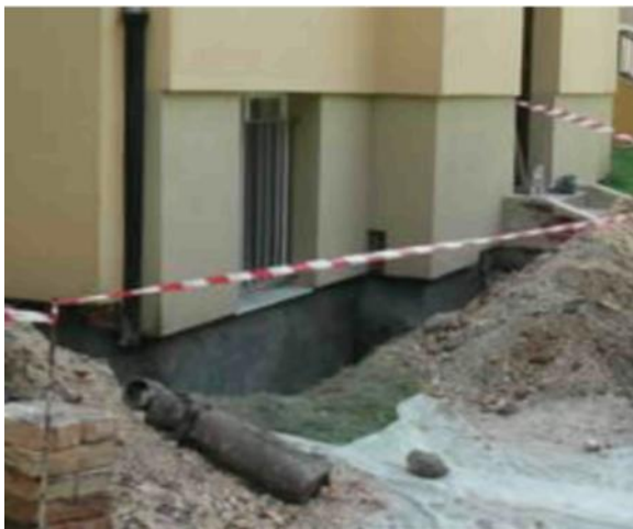
Рисунок.3.7 – «Відмова» роботи гідроізоляції внаслідок неправильно обраного шару гідроізоляції (а); порушення герметичності конструкції в результаті пошкодження гідроізоляційного шару (б)
