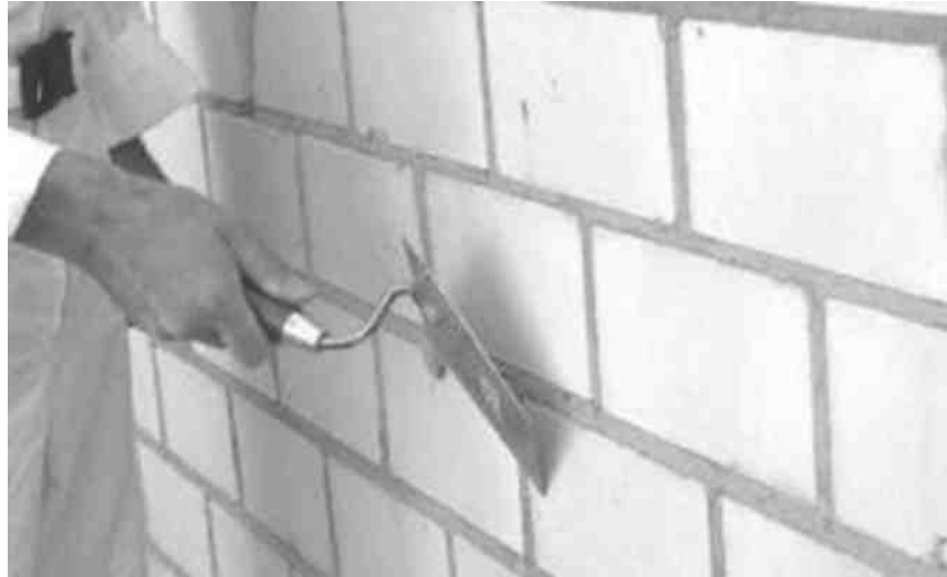
Рисунок 4.2 – Підготовка цегляної поверхні, очищення виступає розчину
