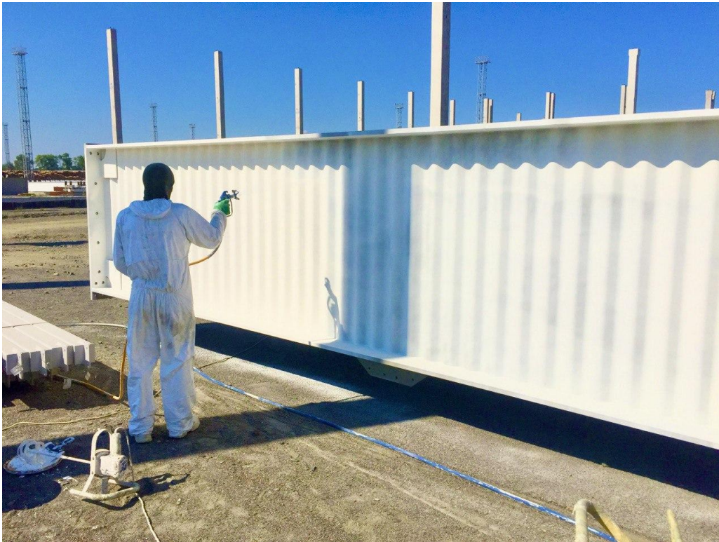
Рисунок 2.2 — Нанесення вогнезахисної фарби
