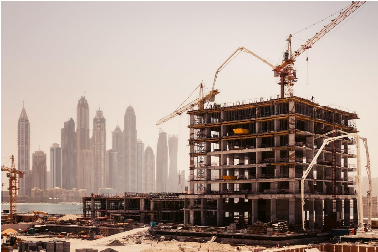
Рисунок 1.4 – Зведення каркасу будівлі з використанням традиційних опалубних систем (м. Дубай, ОАЕ)
