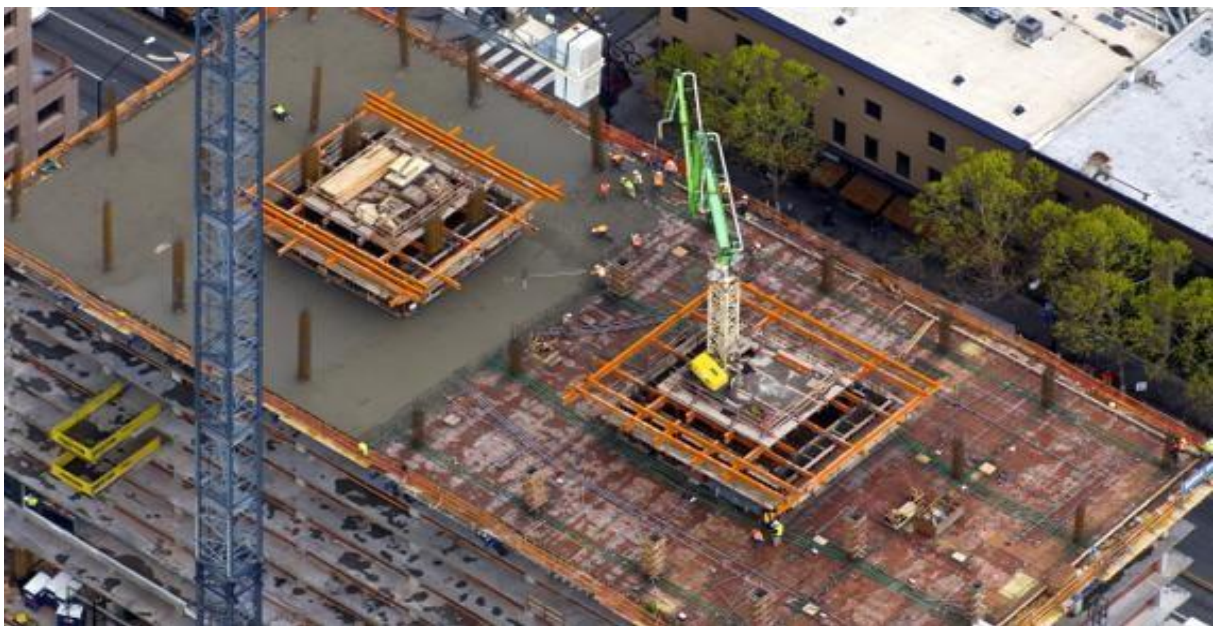
Рисунок 1.3 – Бетонування конструкцій самопідйомною гідравлічною розподільною стрілою Putzmeister (м. Лос-Анджелес, США)
