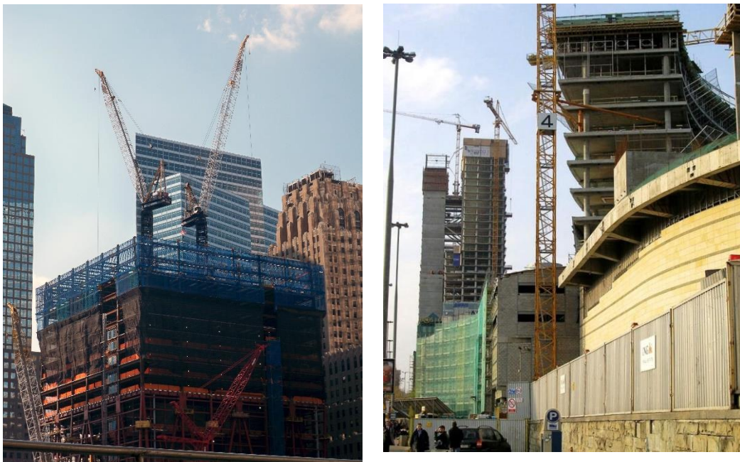
Рисунок 1.7 – Зведення каркасу будівлі “RONDO” № 1 за допомогою приставних баштових кранів (м. Варшава, Польща)
