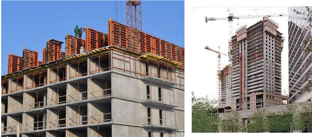
Рисунок 1.5 – Зведення будівлі “The Grand Plaza” за допомогою систем ковзної опалубки Peri ACG (м. Чикаго, США)
