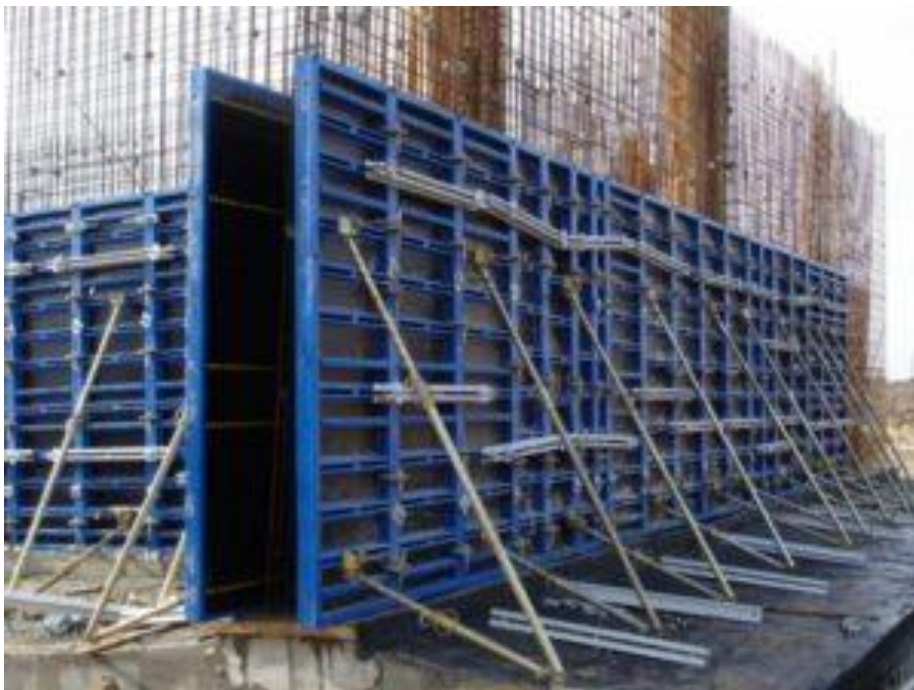
Рисунок 3.1 – Фрагмент пластмасової розбірно-переставної опалубки
