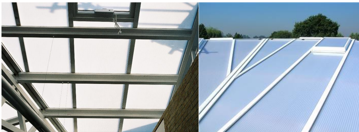
Рисунок 2.13 - Використання світлопрозорих конструкцій на основі аерогелю
