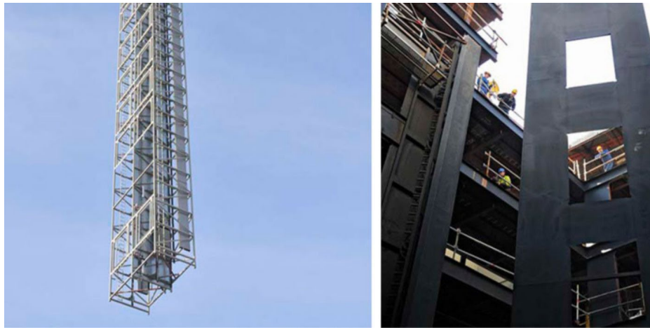
Рисунок 1.7 – Модульне будівництво висотних будівель
