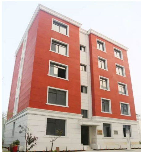
Рисунок 2.10 - WinSun 3D-друкована 5-поверхова будівля
