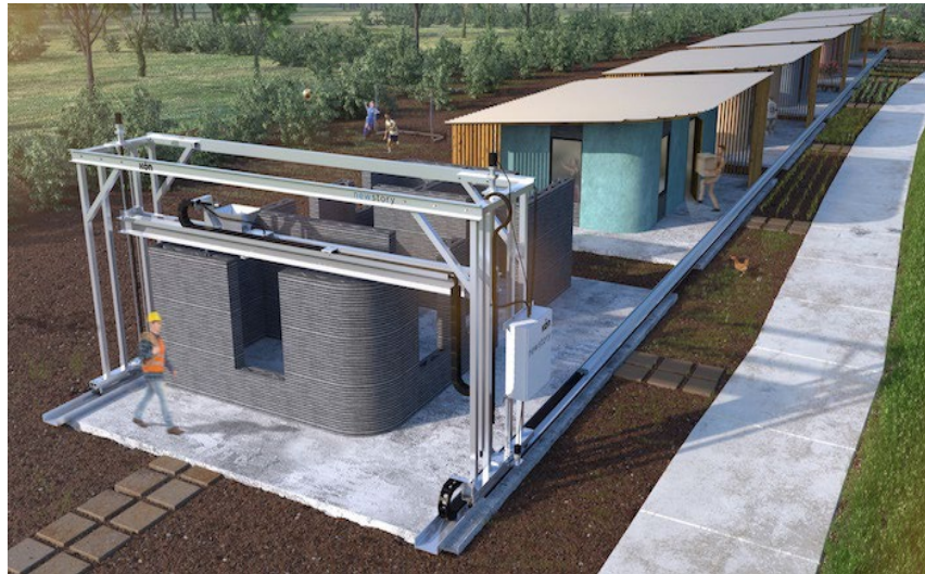
Рисунок 2.8 - 3D-друкована будівля ICON and New Story
