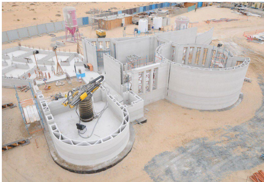
Рисунок 2.7 – Збудована на виробничому принтері будинок компанії Apis Cor
