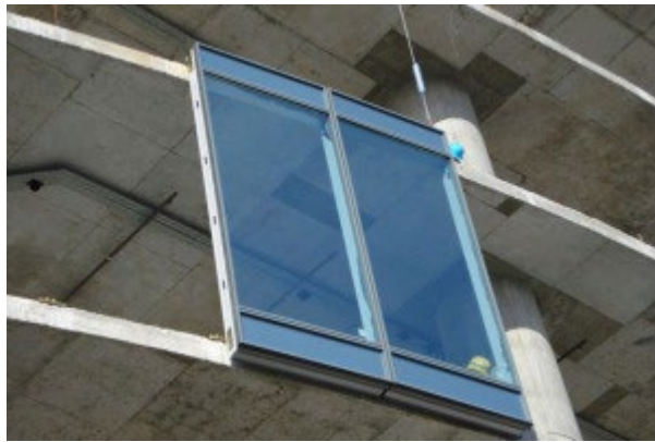
Рисунок 3.2 – Модульна технологія фасадного скління
