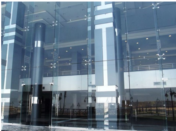
Рисунок 1.2 – Спайдерне скління з системою гострим захватам
