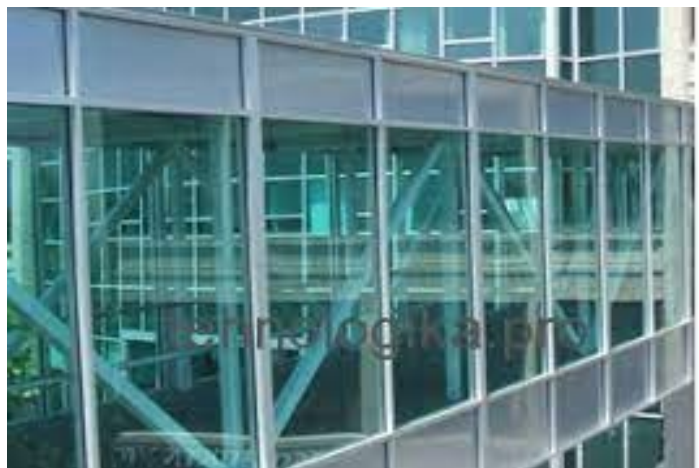
Рисунок 1.1 – Алюмінієві профілі вітражного скління
