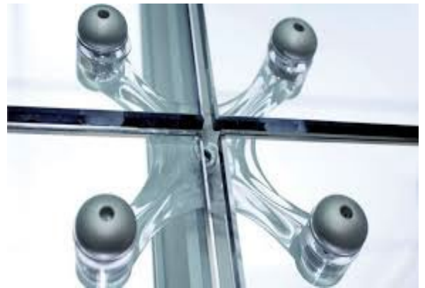
Рисунок 1.2 – Спайдерне скління з системою гострим захватам
