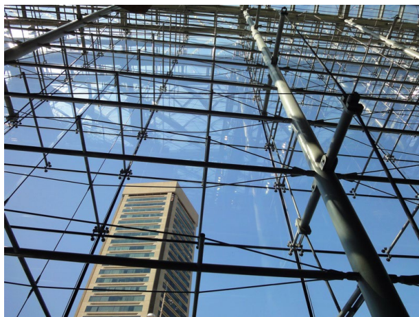
Рисунок 3.3 – Спайдерна схема скління фасаду
