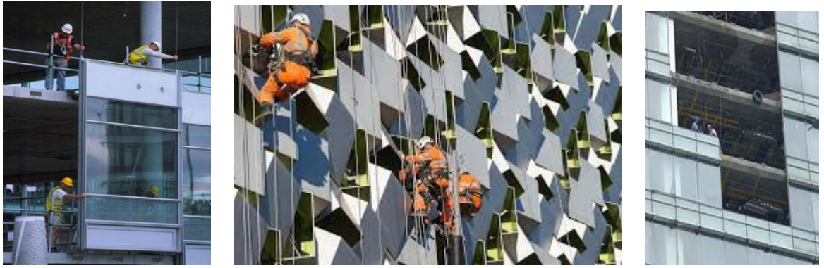
Рисунок 1.12.1 – The Hearst Tower, Нью-Йорк, арх. Foster and Partners: с) конструктивна система (фото)
