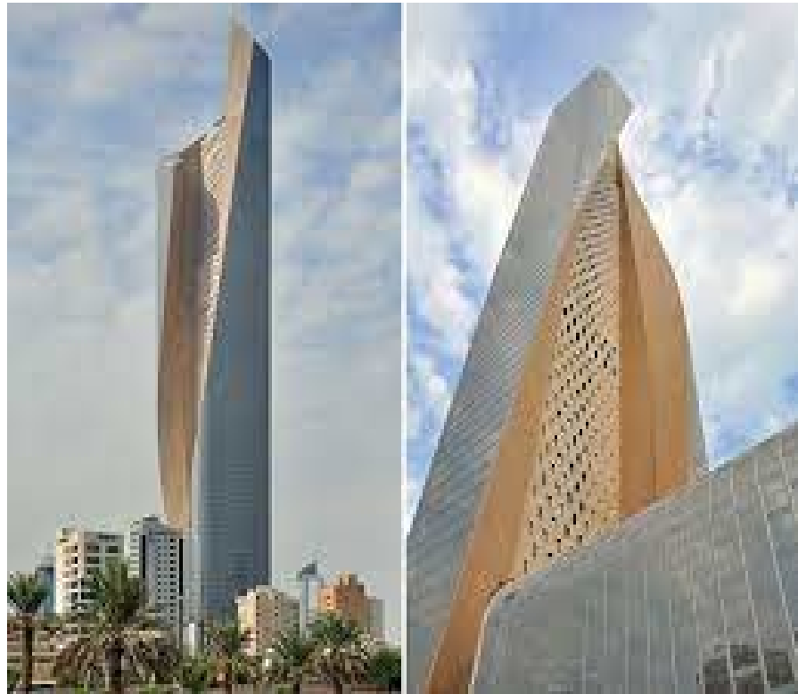
Рисунок 1.5 – а) Al Hamra Firdous Tower, Кувейт, арх. SOM (проникненню тепла до будівлі з південного боку перешкоджає бетонна стіна)
