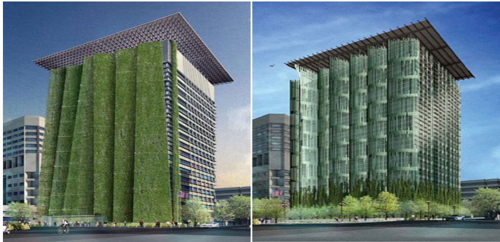
Рисунок 1.6 – б) Portland Federal Building, Портленд, штат Орегон, США (арх. SERA Architects. Вертикальне озеленення фасаду - "природна" сонцезахисна конструкція)
