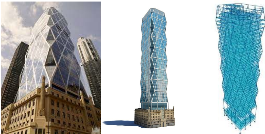
Рисунок 1.12 – The Hearst Tower, Нью-Йорк, арх. Foster and Partners, застосування ефективних сучасних конструкцій в енергоефективному висотному офісному будинку (а-с):
