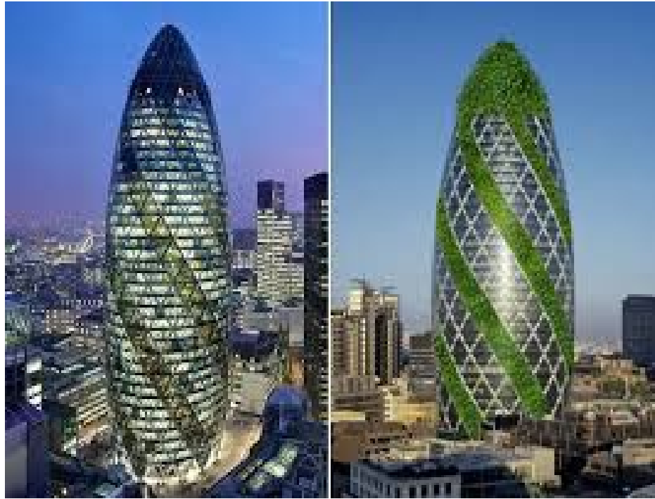
Рисунок 1.4 – Будівля 30 St Mary Axe, Лондон, арх. Foster and Partners:
